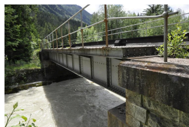
Vue de la face aval du pont enjambant le torrent de l'Arve Phot. Samir Mahfoudi IVR84_20207401200NUCA
