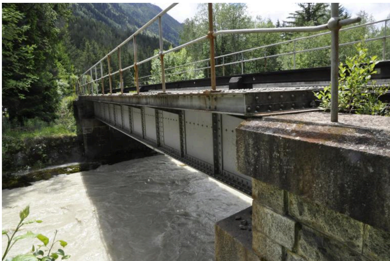
Vue de la face aval du pont enjambant le torrent de l'Arveyron
