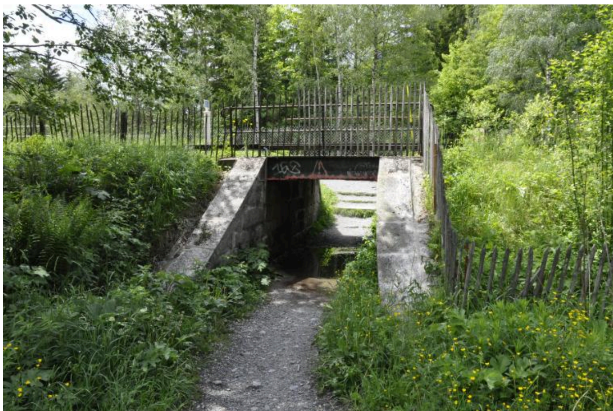
Vue de la face sud-est du pont surplombant le chemin donnant accès au chemin des Lots
