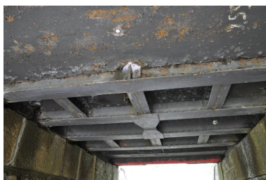
Détail du tablier du ponceau avec deux poutres jumelles sous rail Phot. Samir Mahfoudi IVR84_20207401302NUCA
