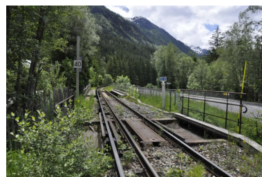
La voie ferroviaire portée par ces deux ouvrages Phot. Samir Mahfoudi IVR84_20207401303NUCA
