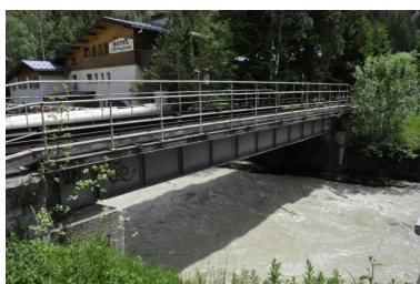
Vue du tablier métallique du pont enjambant le torrent de l'Arve prise depuis la rive gauche Phot. Samir Mahfoudi IVR84_20207401199NUCA
