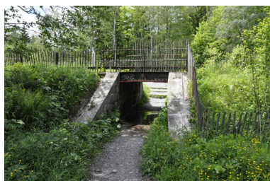
Vue de la face sud-est du pont surplombant le chemin donnant accès au chemin des Lots Phot. Samir Mahfoudi IVR84_20207401301NUCA
