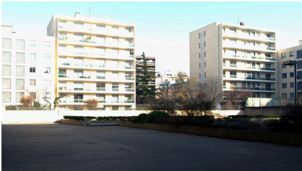
Elévation sur cour, depuis le sud
