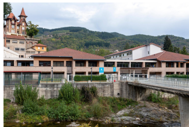
Vue d'ensemble. Phot. Michel Pérès IVR84_20200700113NUCA
