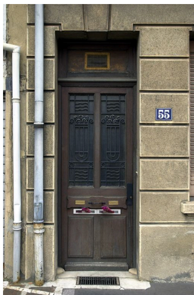
Immeuble, façade sur le boulevard, porte Phot. Véronique Belle IVR82_20036902130NUCA
