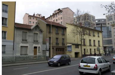
Vue générale parmi les autres constructions à démolir Phot. Véronique Belle IVR82_20036902122NUCA
