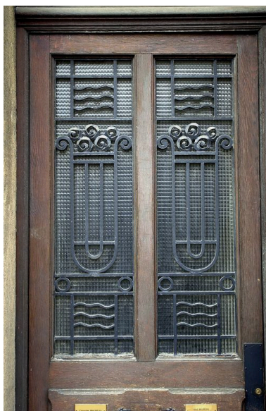
Immeuble, façade sur le boulevard, détail de la grille du vantail de la porte Phot. Véronique Belle IVR82_20036902131NUCA
