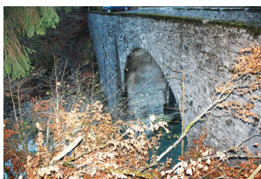
Pont de Couvaloup, face amont Phot. Benoît Huraut IVR84_20207401465NUCA
