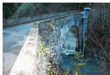
Pont de Couvaloup, face aval Phot. Benoît Huraut IVR84_20207401466NUCA
