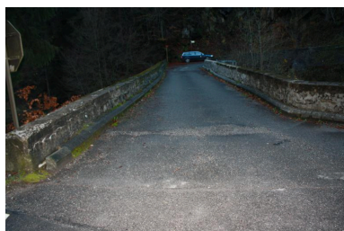
Pont de Couvaloup, chaussée et gardes corps Phot. Benoît Huraut IVR84_20207401467NUCA
