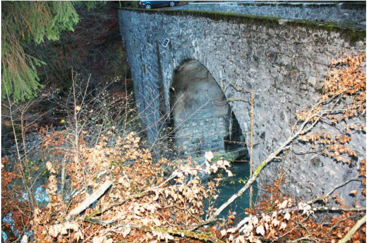
Pont de Couvaloup, face amont
