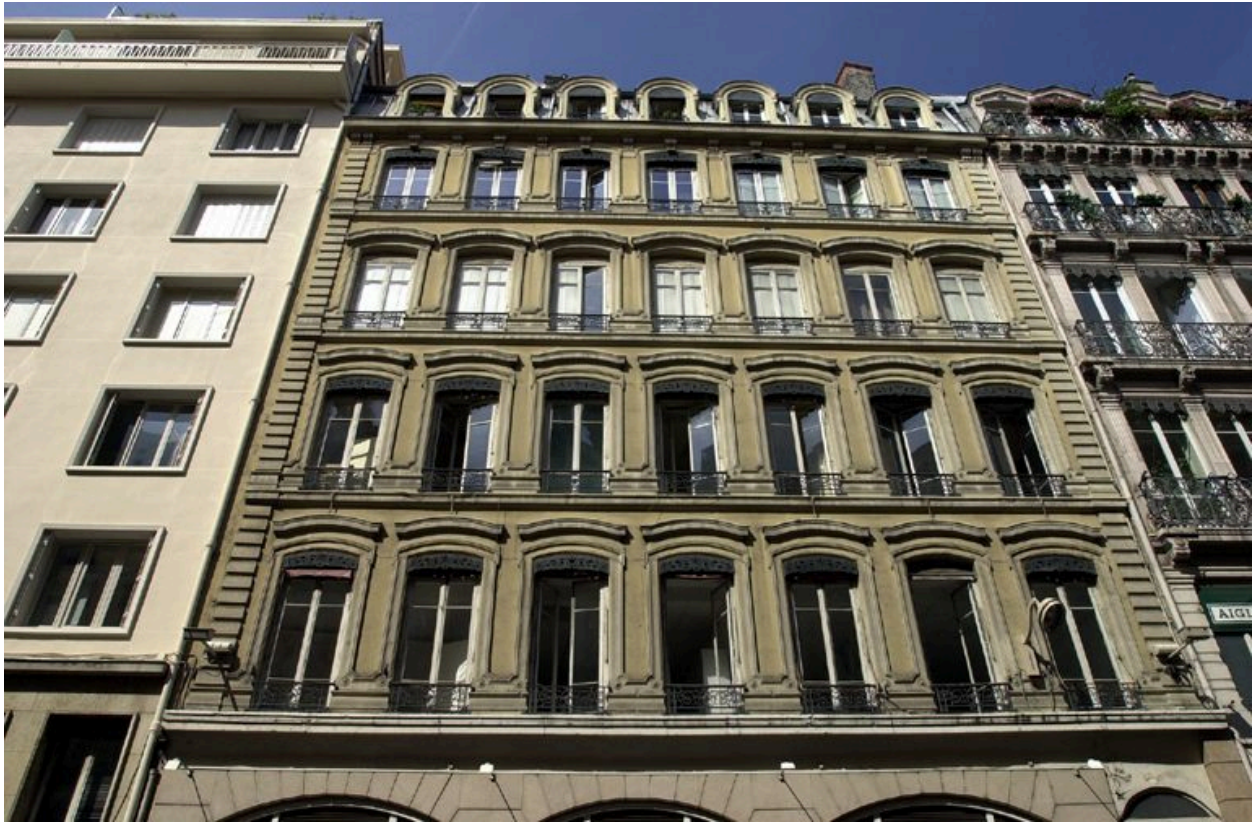
Elévation antérieure : les étages supérieurs
