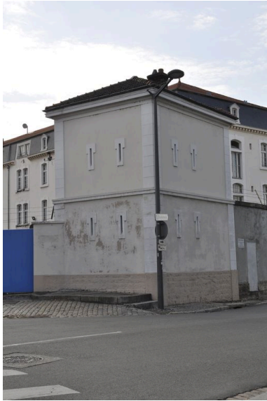
Détail de la guérite située au sud-ouest (côté boulevard de l'Artillerie). Phot. Catherine Guégan IVR82_20116902169NUCA
