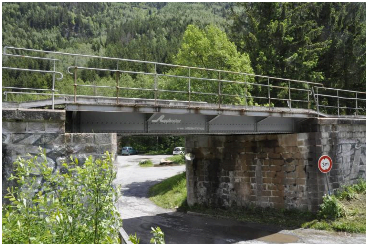
Vue de la face est de l'ouvrage
