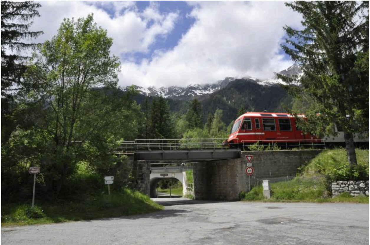
Vue générale de l'ouvrage
