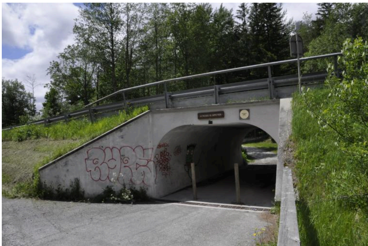
Pont routier dit passage des skieurs du Bouchet faisant face au pont ferroviaire à l'ouest
