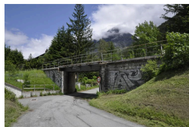
Vue de la face ouest du pont Phot. Samir Mahfoudi IVR84_20207401306NUCA
