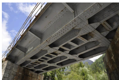
Armature du tablier métallique composé de deux poutres principales et des poutres de rive sous rails Phot. Samir Mahfoudi IVR84_20207401307NUCA
