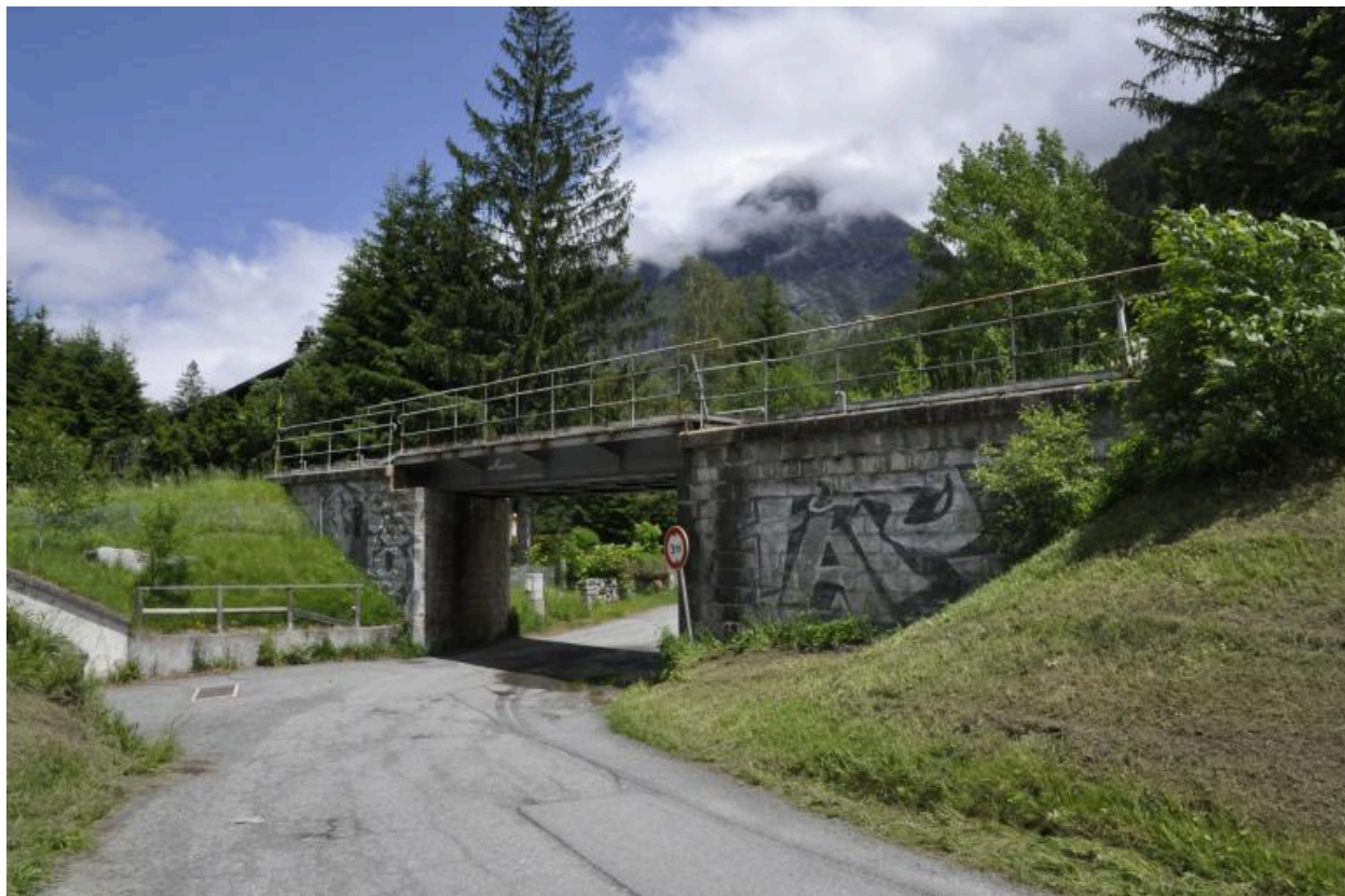
Vue de la face ouest du pont
