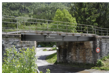
Vue de la face est de l'ouvrage Phot. Samir Mahfoudi IVR84_20207401305NUCA
