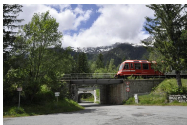
Vue générale de l'ouvrage Phot. Samir Mahfoudi IVR84_20207401304NUCA
