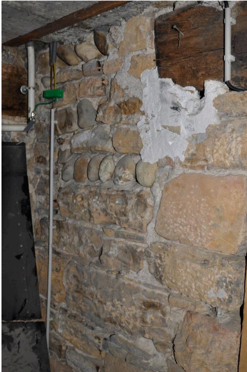
Sous-sol, détail montrant les matériaux des murs en soubassement
