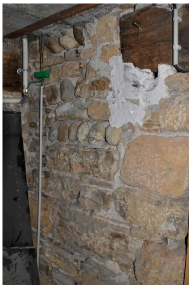
Sous-sol, détail montrant les matériaux des murs en soubassement Phot. Magali Delavenne IVR84_20186900964NUCA
