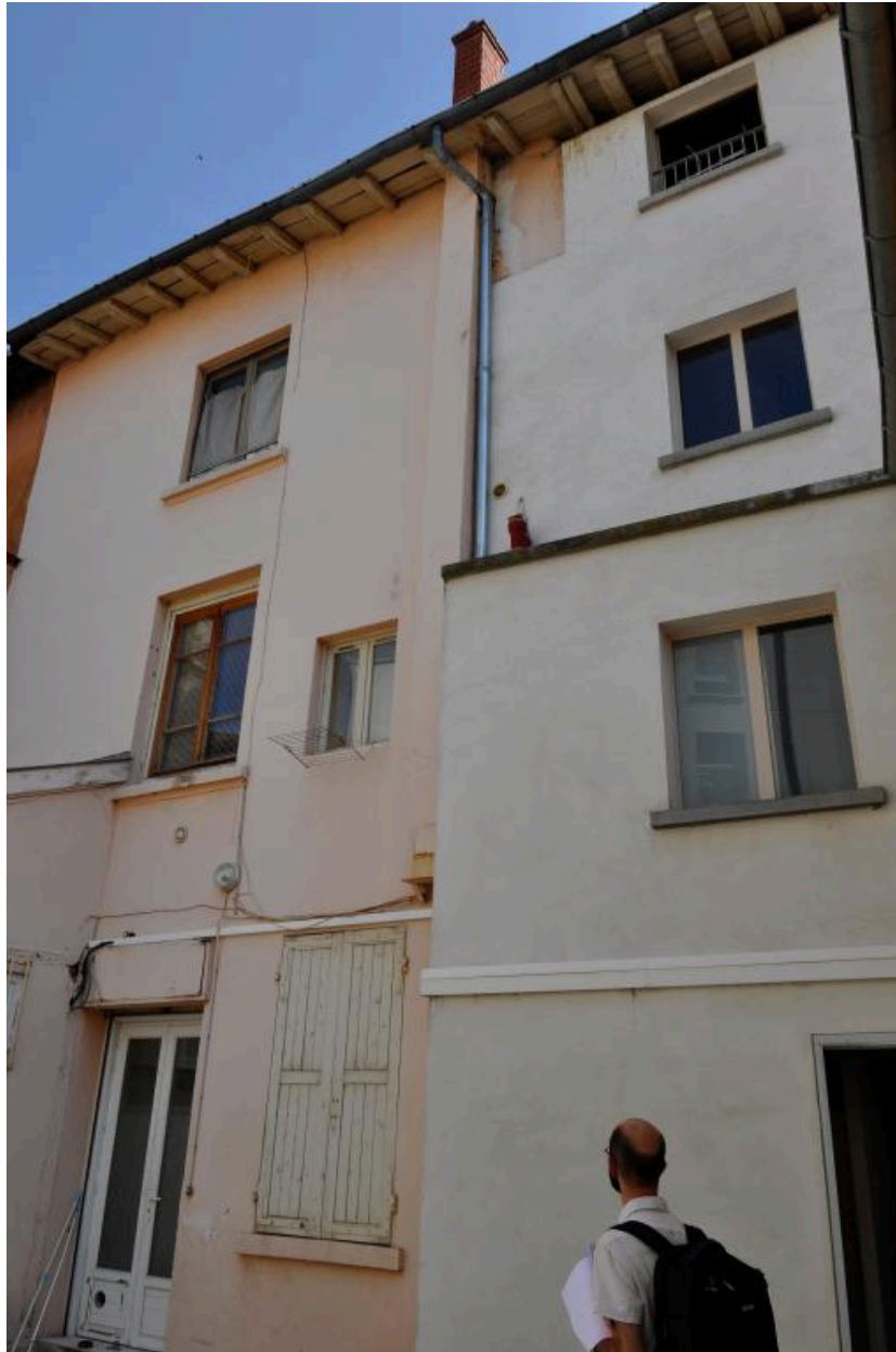
Elévation sur cour, vue partielle
