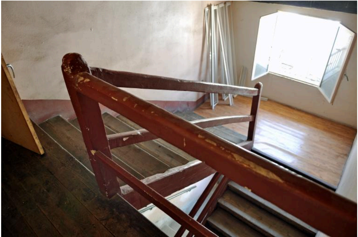
Vue de l'escalier, dernière révolution en bois
