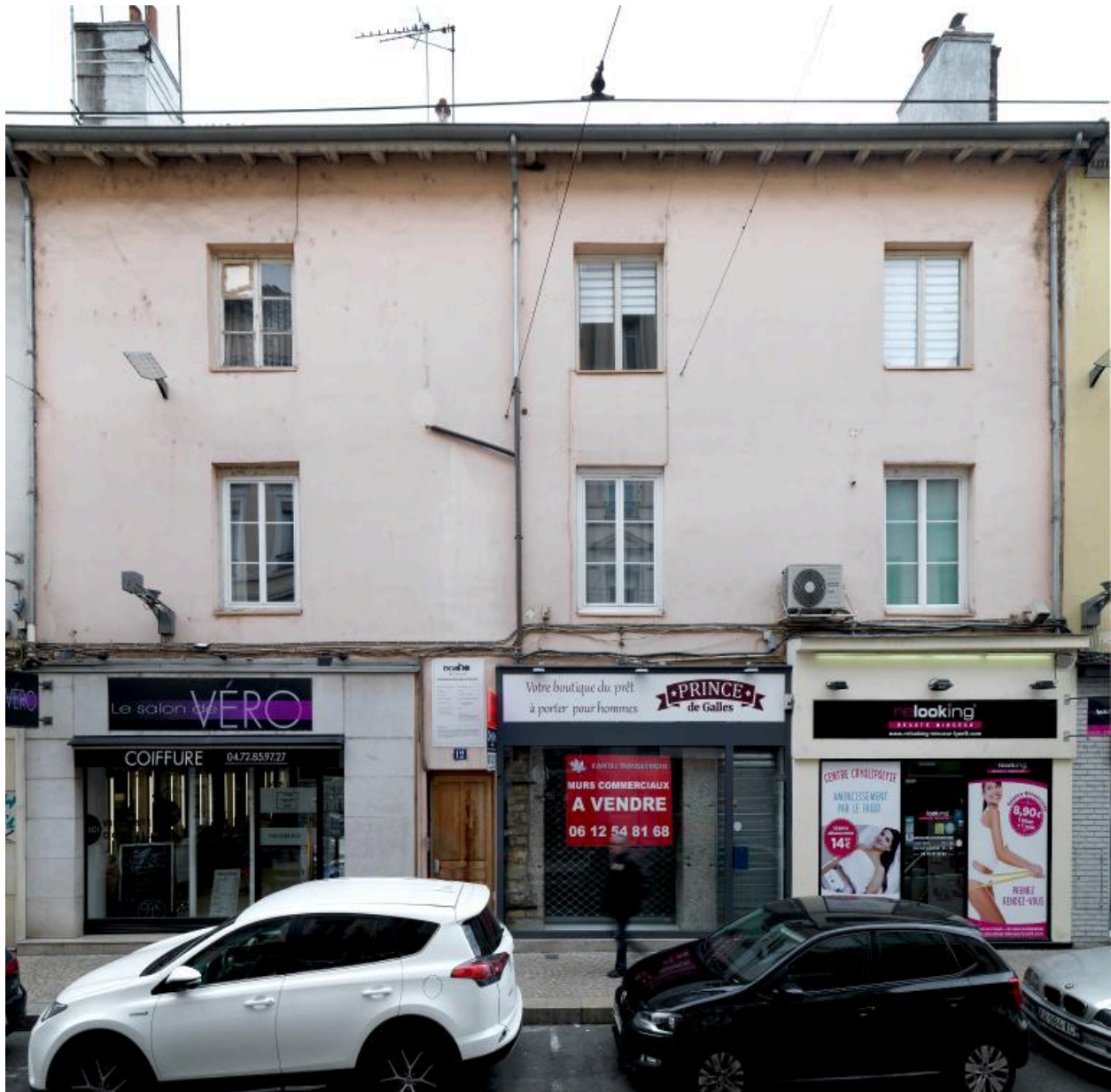
Vue de l'ensemble formé de deux maisons jumelées
