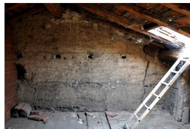
Vue de l'étage de comble, mur pignon en pisé Phot. Magali Delavenne IVR84_20186900970NUCA
