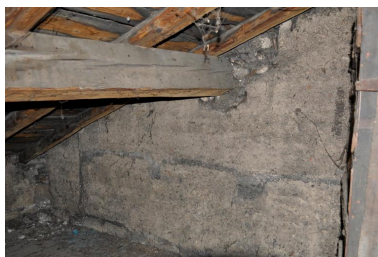
Vue de l'étage de comble, mur de refend en pisé Phot. Magali Delavenne IVR84_20186900972NUCA
