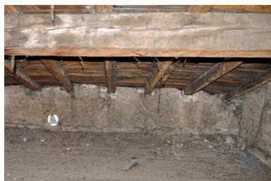
Vue de l'étage de comble, mur gouttereau en pisé Phot. Magali Delavenne IVR84_20186900971NUCA
