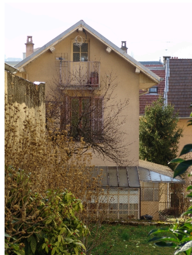
Pignon gauche Phot. François Fouger IVR82_20097300521NUCA
