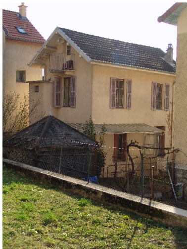
Vue d'ensemble Phot. François Fouger IVR82_20097300522NUCA
