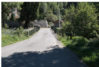
Pont des Doubines, vue de la chaussée et des garde-corps Phot. Pascale Renard IVR84_20207401513NUCA
