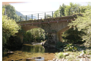
Pont des Doubines, vue de la face aval Phot. Pascale Renard IVR84_20197401233NUCA
