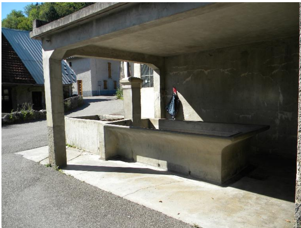
Vue du lavoir couvert.
