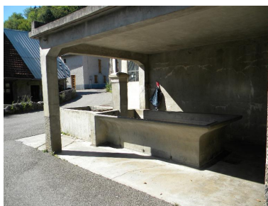
Vue du lavoir couvert. Phot. Jérôme Daviet IVR82_20137400996NUCA
