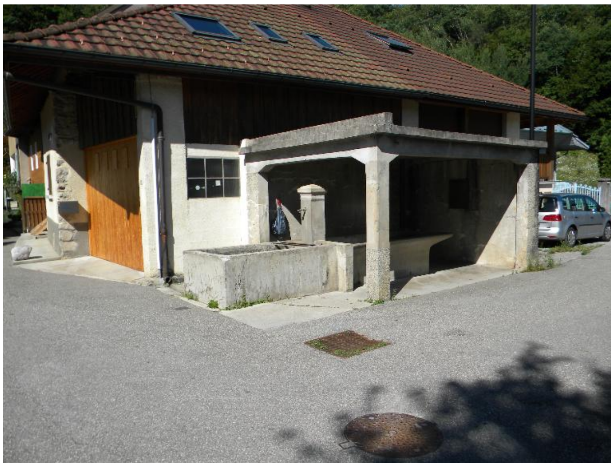
Vue d'ensemble du bassin et lavoir couvert.
