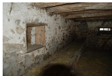
Intérieur de l'étable avec les rateliers en bois et ouverture pour le chargement en foin de la crèche. Phot. Thierry Monnet IVR84_20187400038NUCA
