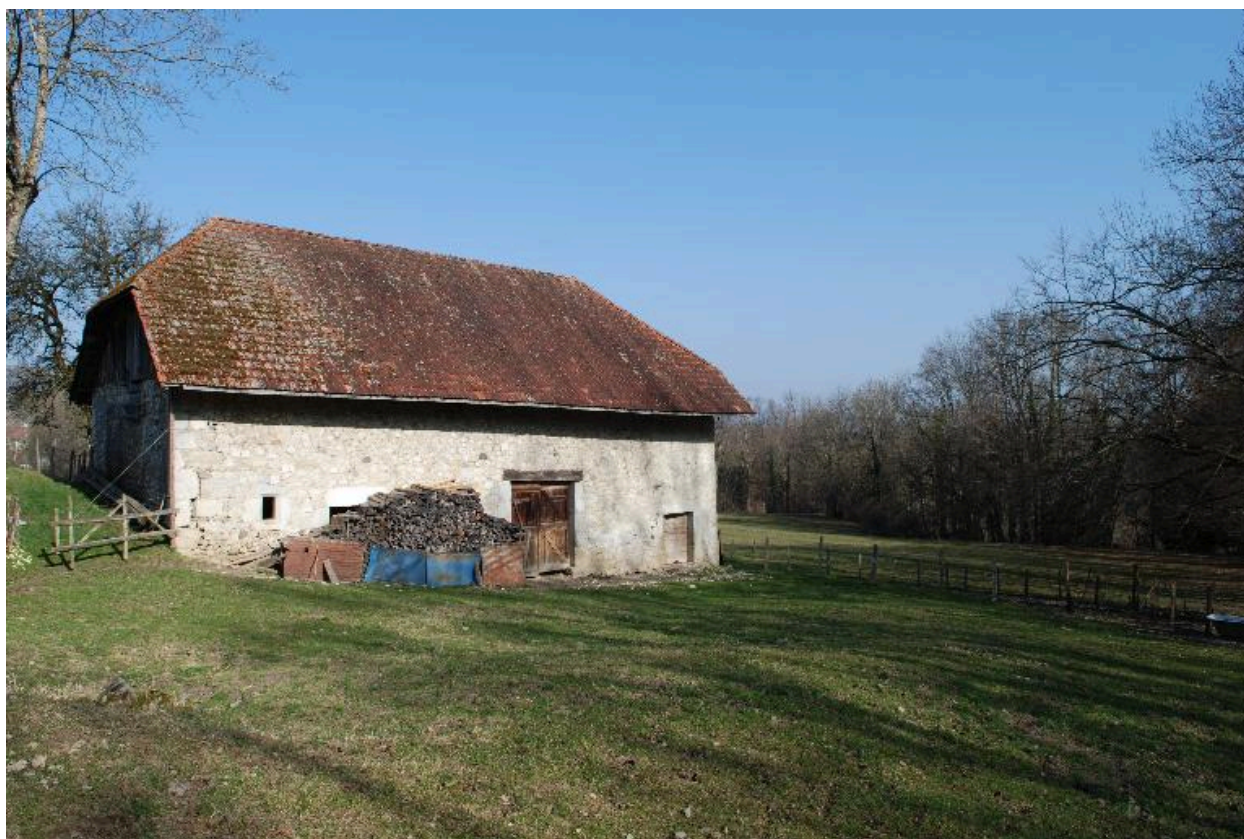
Vue d'ensemble de trois-quarts avant gauche.
