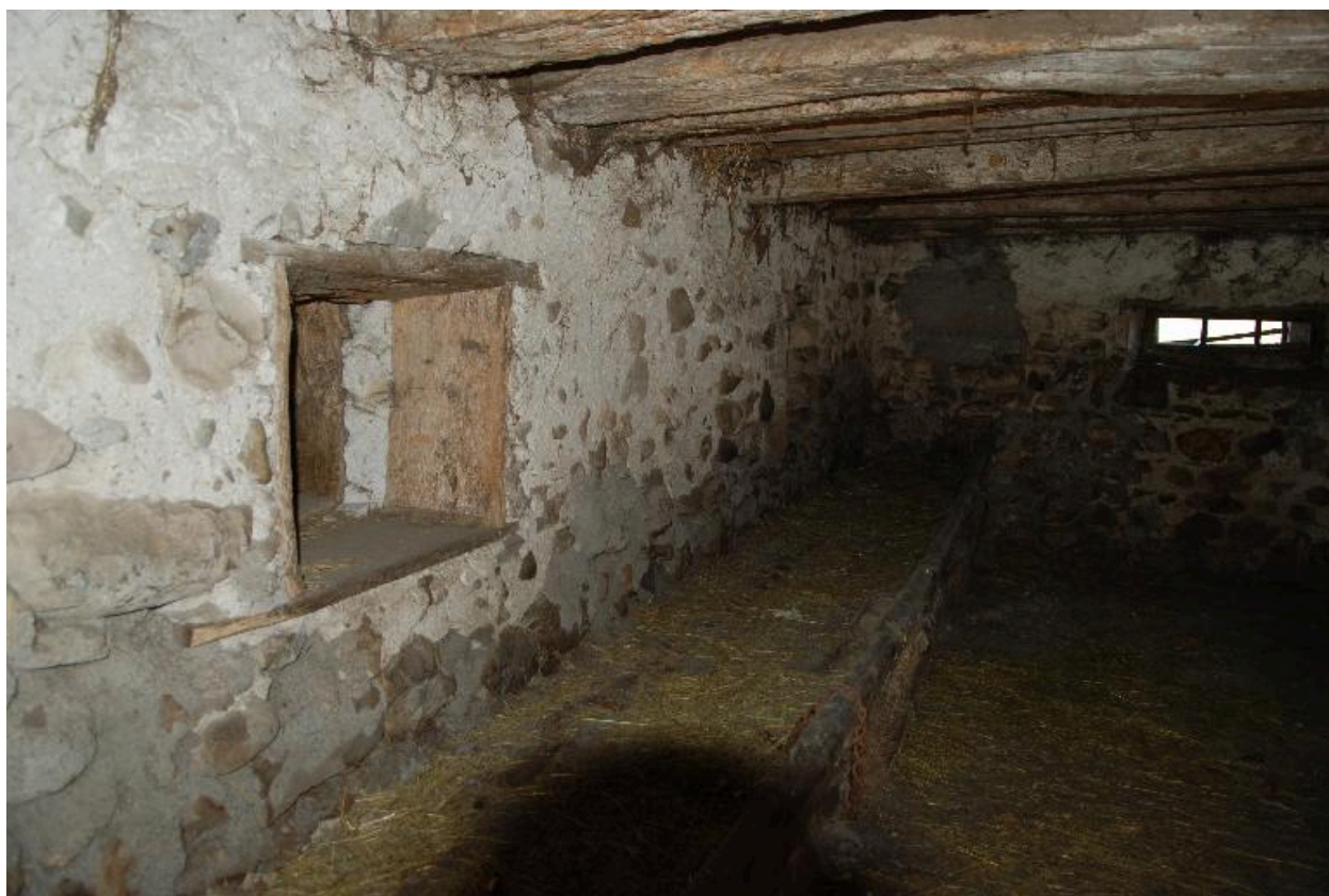
Intérieur de l'étable avec les rateliers en bois et ouverture pour le chargement en foin de la crèche.
