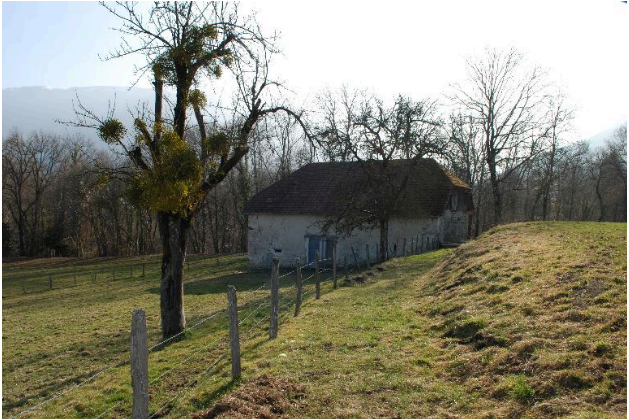
Vue d'ensemble de la grange dans son site de trois-quarts arrière droit
