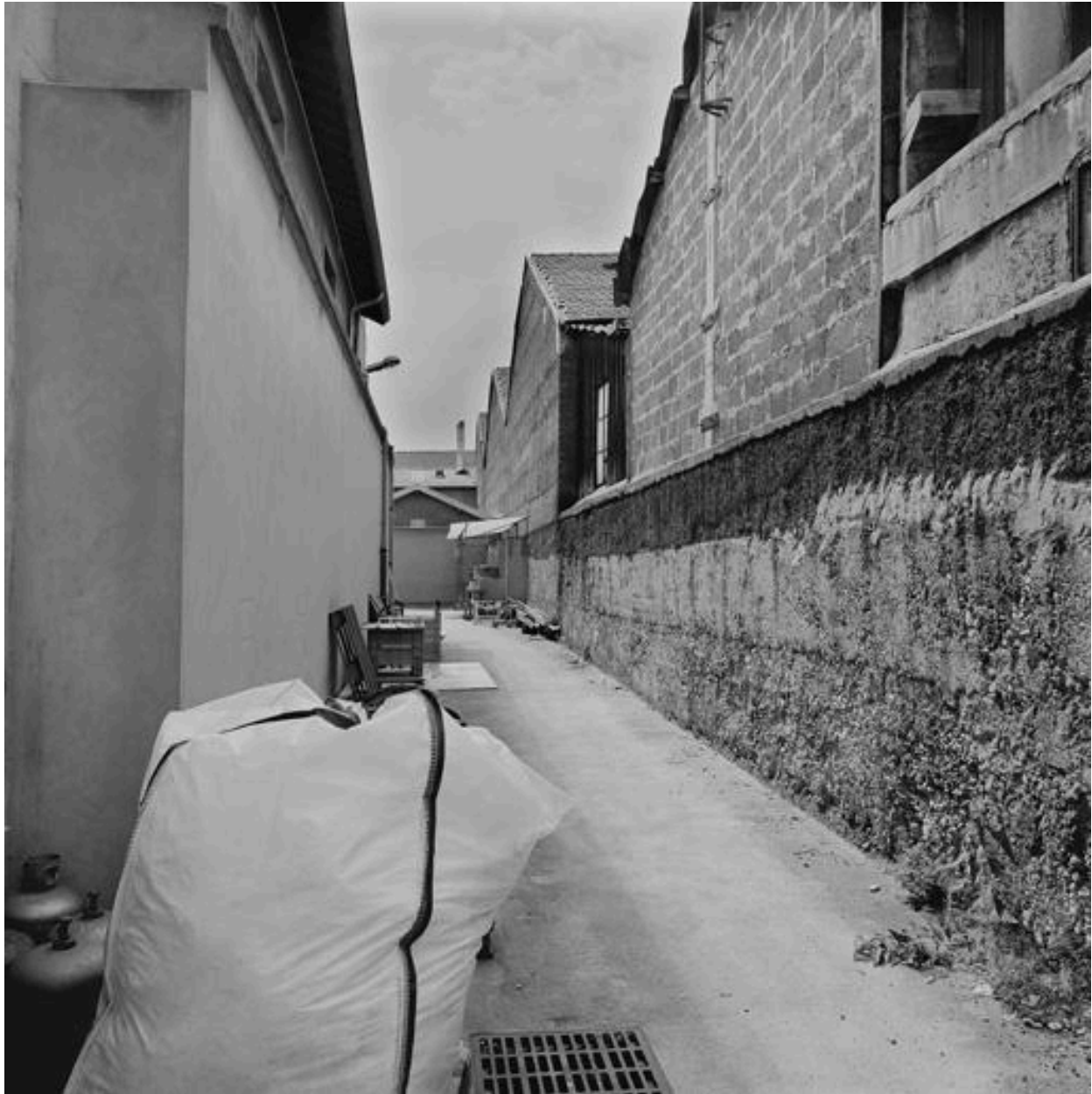
Vue des circulations intérieures
