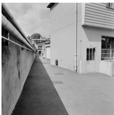
Détail circulation extérieure Phot. Didier Gourbin IVR82_20076903121X
