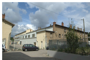
Vue sud-est des ateliers, ancien bâtiment antérieur à la société Babolat ? Phot. Nadine Halitim-Dubois IVR82_20086900376NUCA
