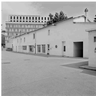
Façade atelier Phot. Didier Gourbin IVR82_20076903127X
