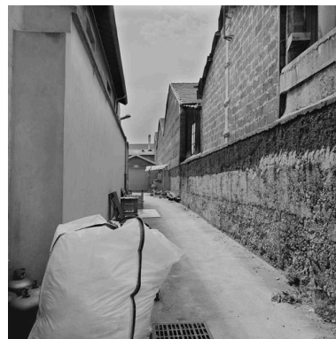
Vue des circulations intérieures Phot. Didier Gourbin IVR82_20076903125X
