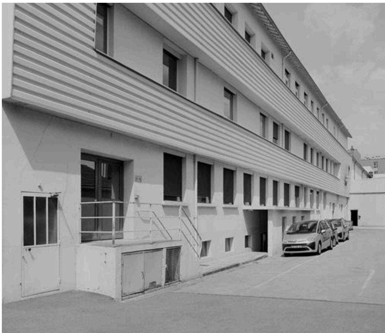
Façade atelier des cordages
