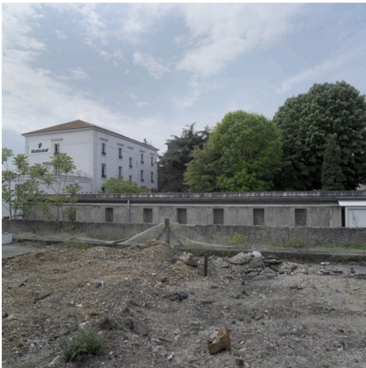
Vue générale impasse des cures et bâtiment principal
