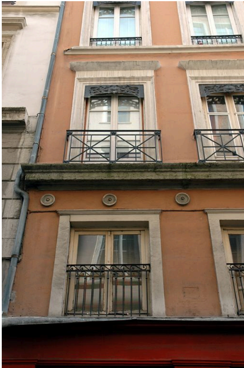
Vue partielle de l'élévation antérieure
