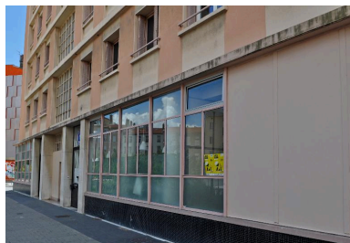
Vue rapprochée du rez-de-chaussée sur rue Robert-Cluzan Phot. Catherine Guégan IVR84_20166900762NUCA
