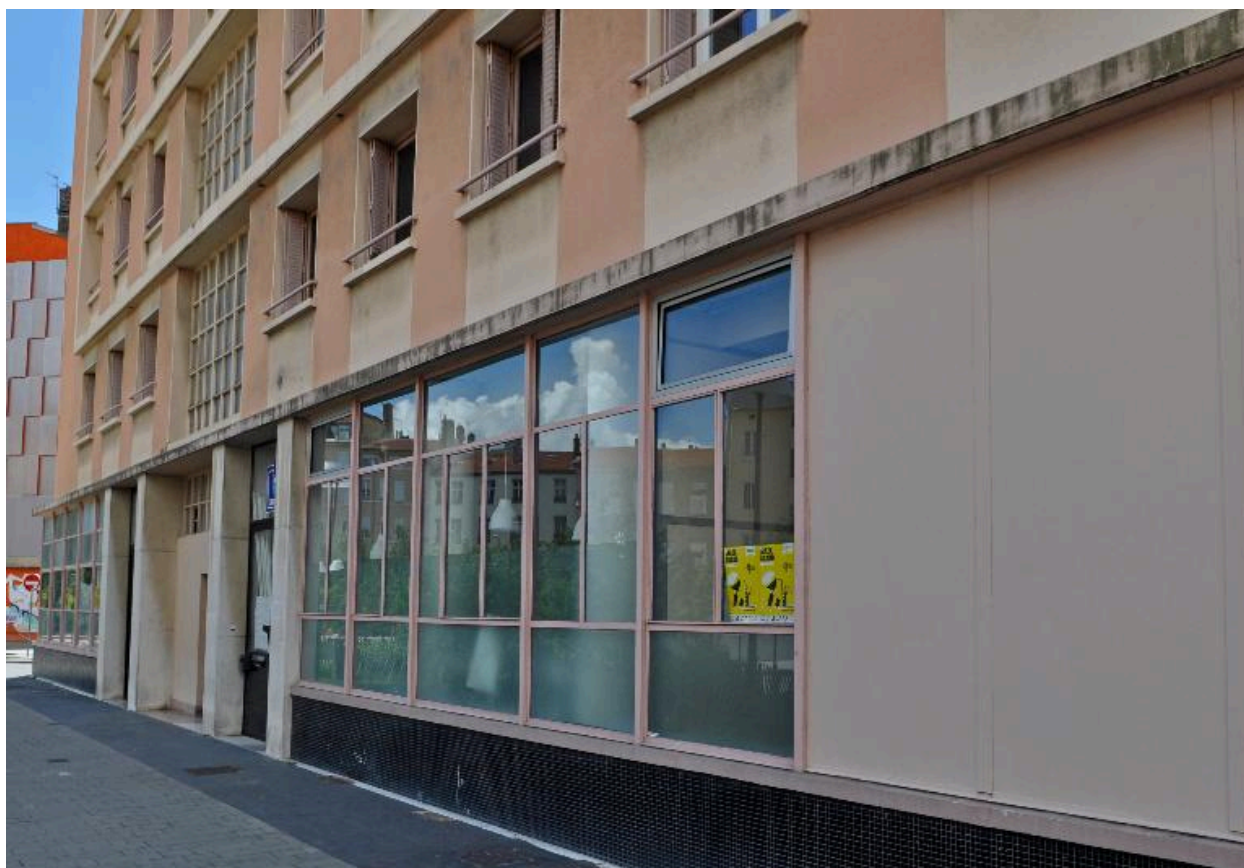
Vue rapprochée du rez-de-chaussée sur rue Robert-Cluzan
