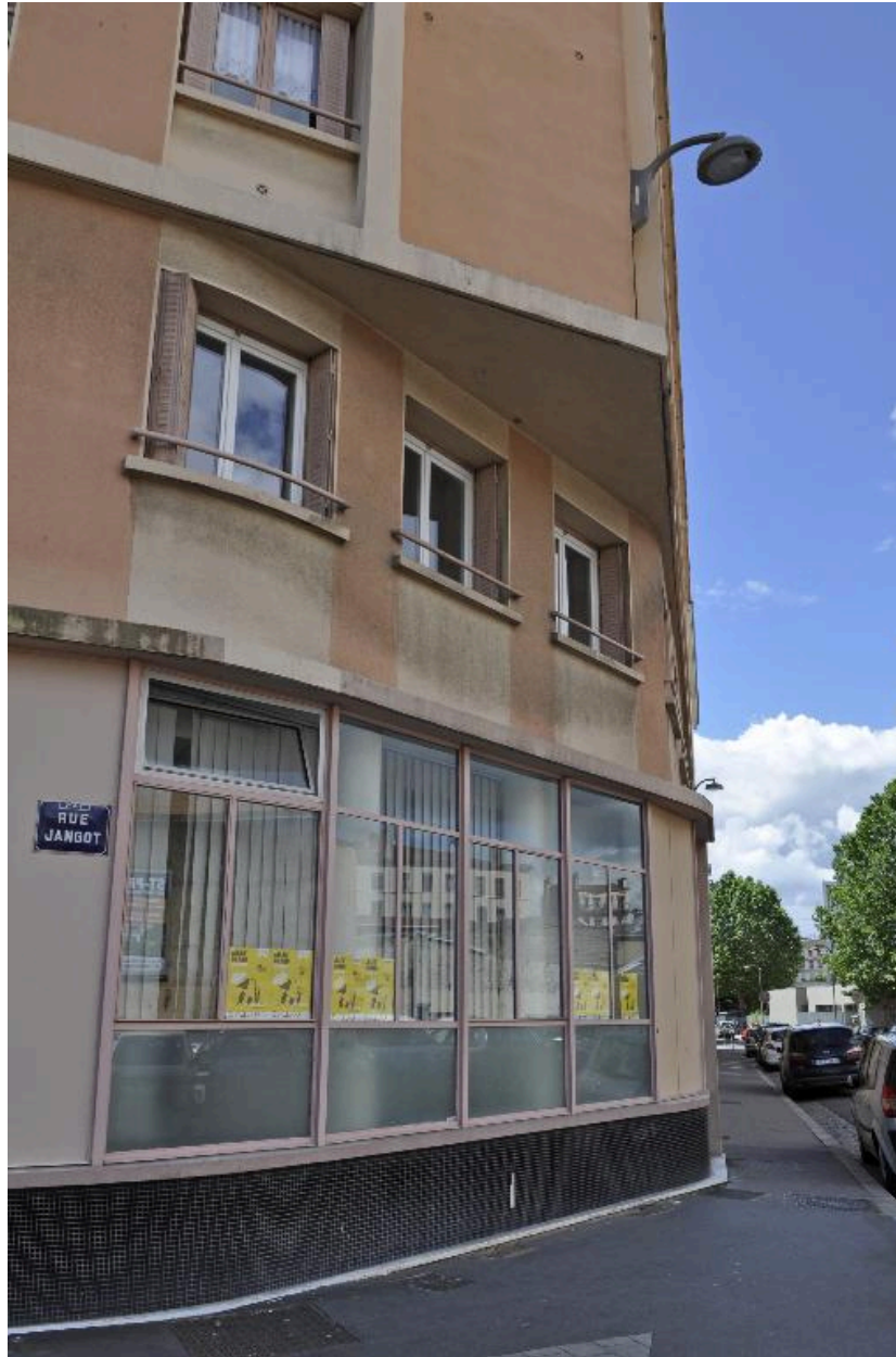
Vue rapprochée de l'angle : rez-de-chaussée et premier étage en retrait formant pan coupé
