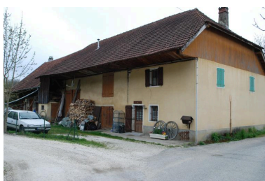
Vue d'ensemble de trois-quats avant droit de la ferme n° 506 Phot. Thierry Monnet IVR84_20187400340NUCA
