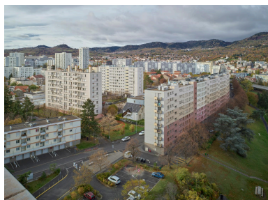
Vue depuis la terrasse de l'immeuble situé 1-3 allée des Dômes, faisant partie du grand ensemble. Phot. Christian Parisey IVR84_20206301070NUCA
