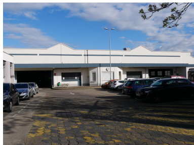
Vue d'ensemble dépôt TCL Moulin à vent Phot. Nadine Halitim-Dubois IVR84_20246900469NUCA
