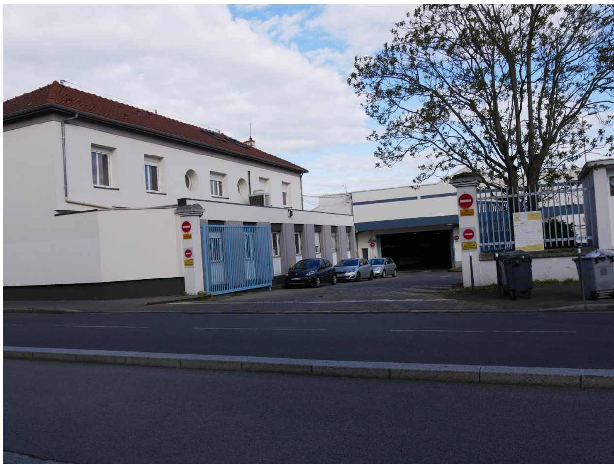
Vue des différents bâtiments du dépôt
