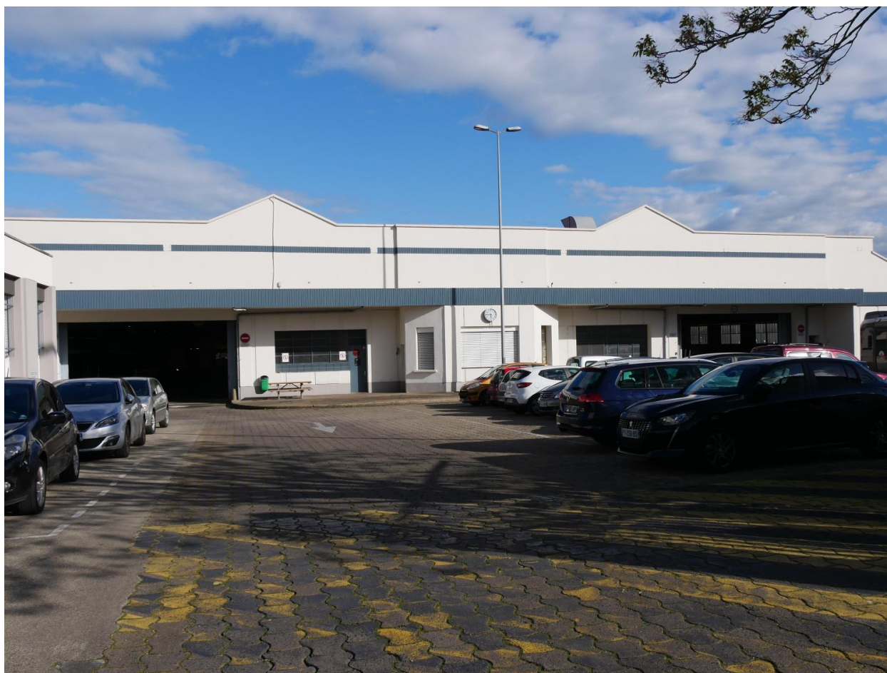
Vue d'ensemble dépôt TCL Moulin à vent
