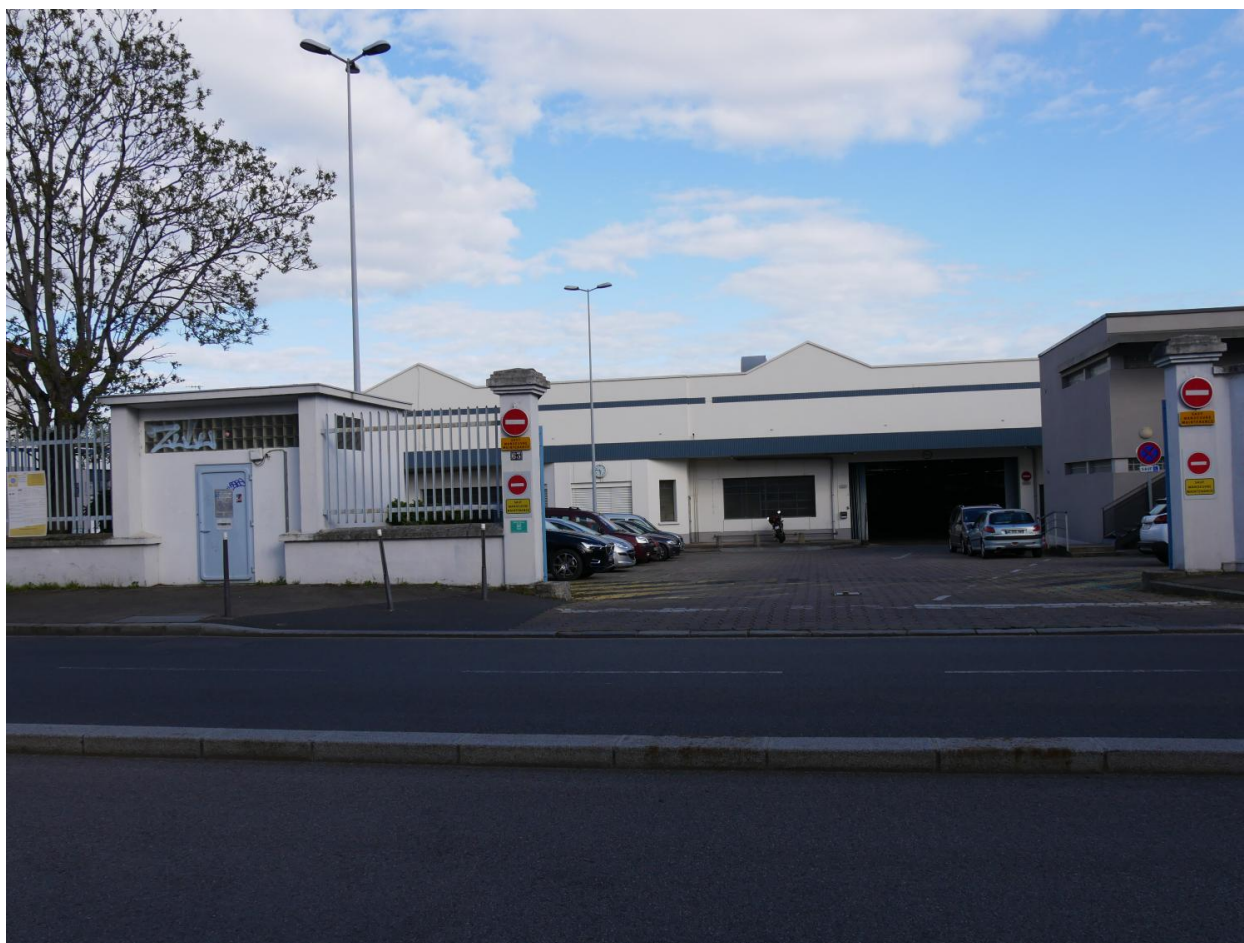
Vue des différents bâtiments du dépôt
