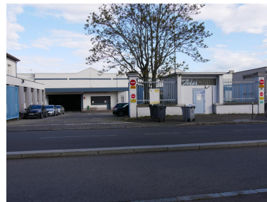
Vue des entrepôts Phot. Nadine Halitim-Dubois IVR84_20246900471NUCA
