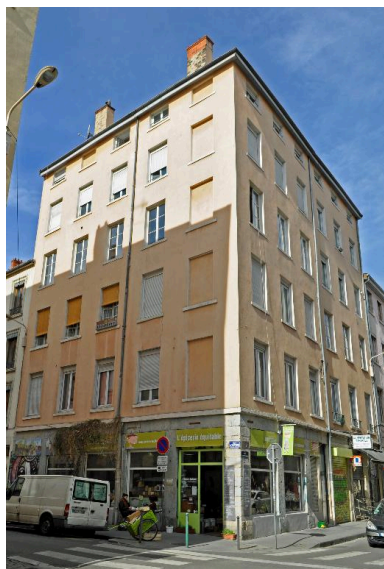
Vue d'ensemble, depuis le nord-est Phot. Catherine Guégan IVR84_20176901091NUCA
