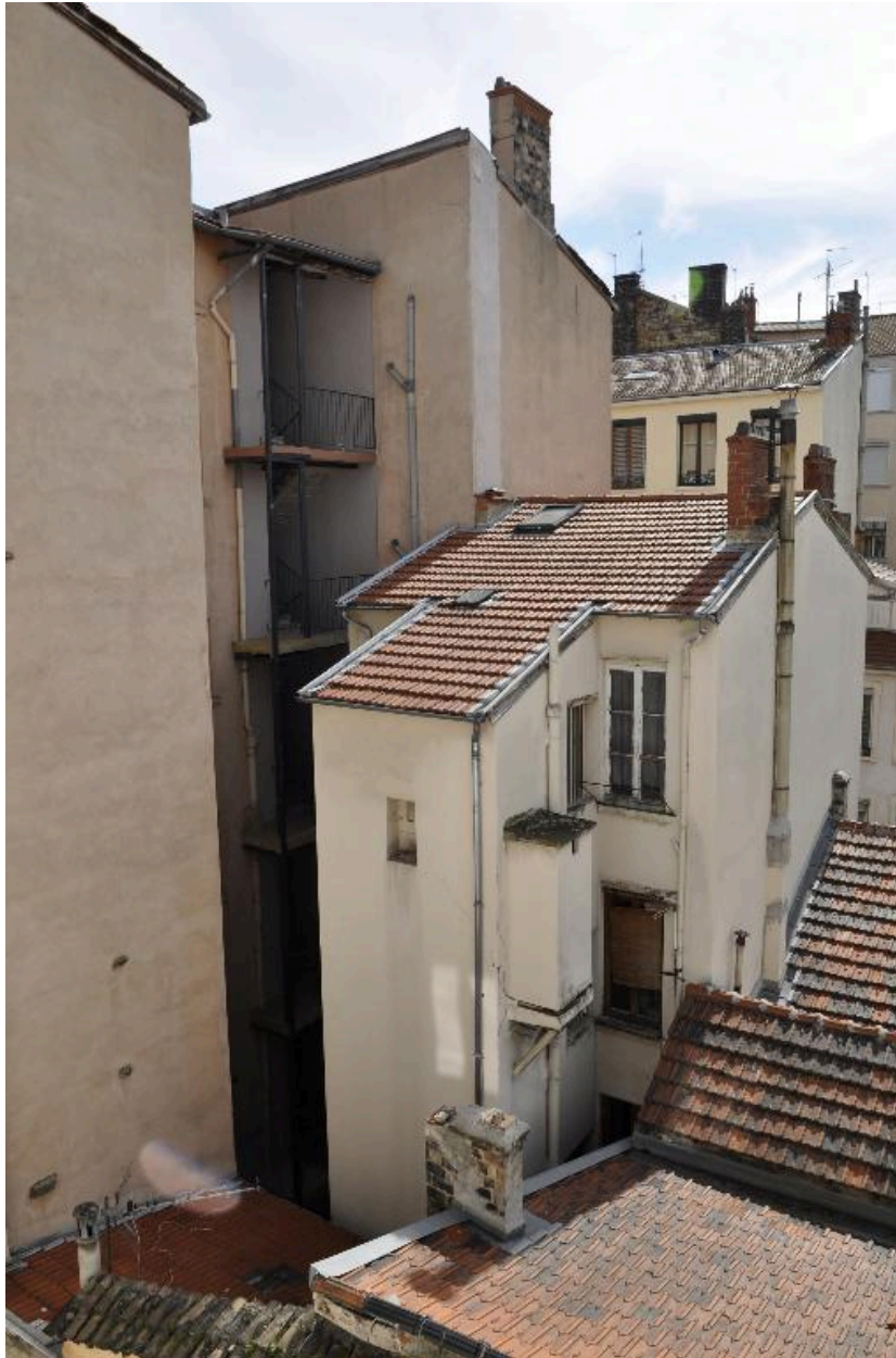
Vue partielle des élévations postérieures, avec le palier de l'escalier à cage ouverte au centre des deux retours
