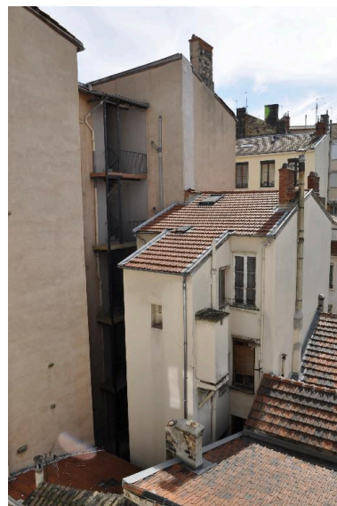
Vue partielle des élévations postérieures, avec le palier de l'escalier à cage ouverte au centre des deux retours Phot. Catherine Guégan IVR84_20176901089NUCA
