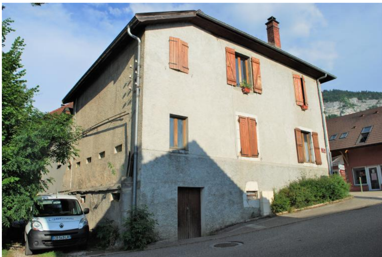
Vue d'ensemble de trois-quarts arrière droit
