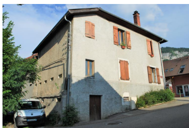
Vue d'ensemble de trois-quarts arrière droit
