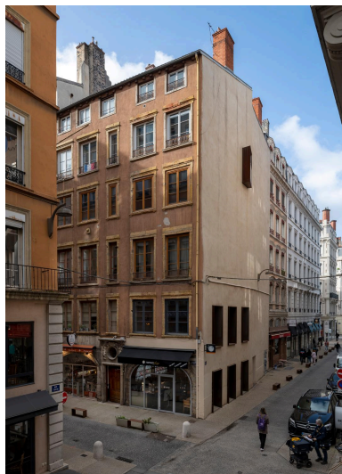
Vue générale Phot. Michel Pérès IVR84_20226900191NUCA
