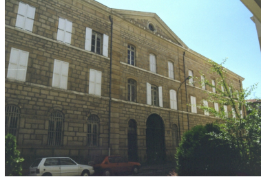
Façade principale. Etat en 1996 Phot. Cendrine Sanquer IVR82_19974201980ZE
