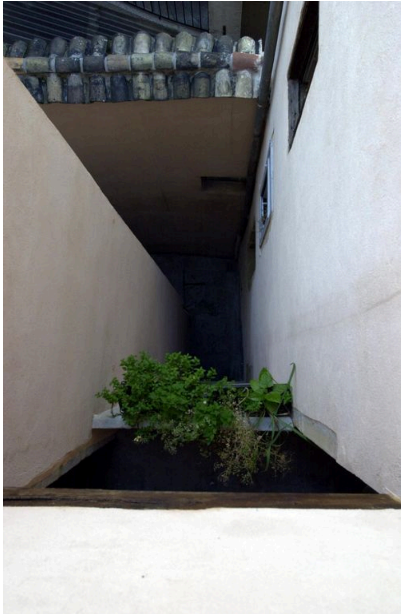
Cour, ensemble des galeries, vue depuis le haut, entre la tour d'escalier à gauche et le 2e corps de bâtiment à droite
