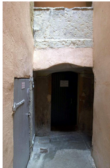
Cour, galeries, élévation du 1er niveau Phot. François Blanchetière IVR82_20016901482NUCA
