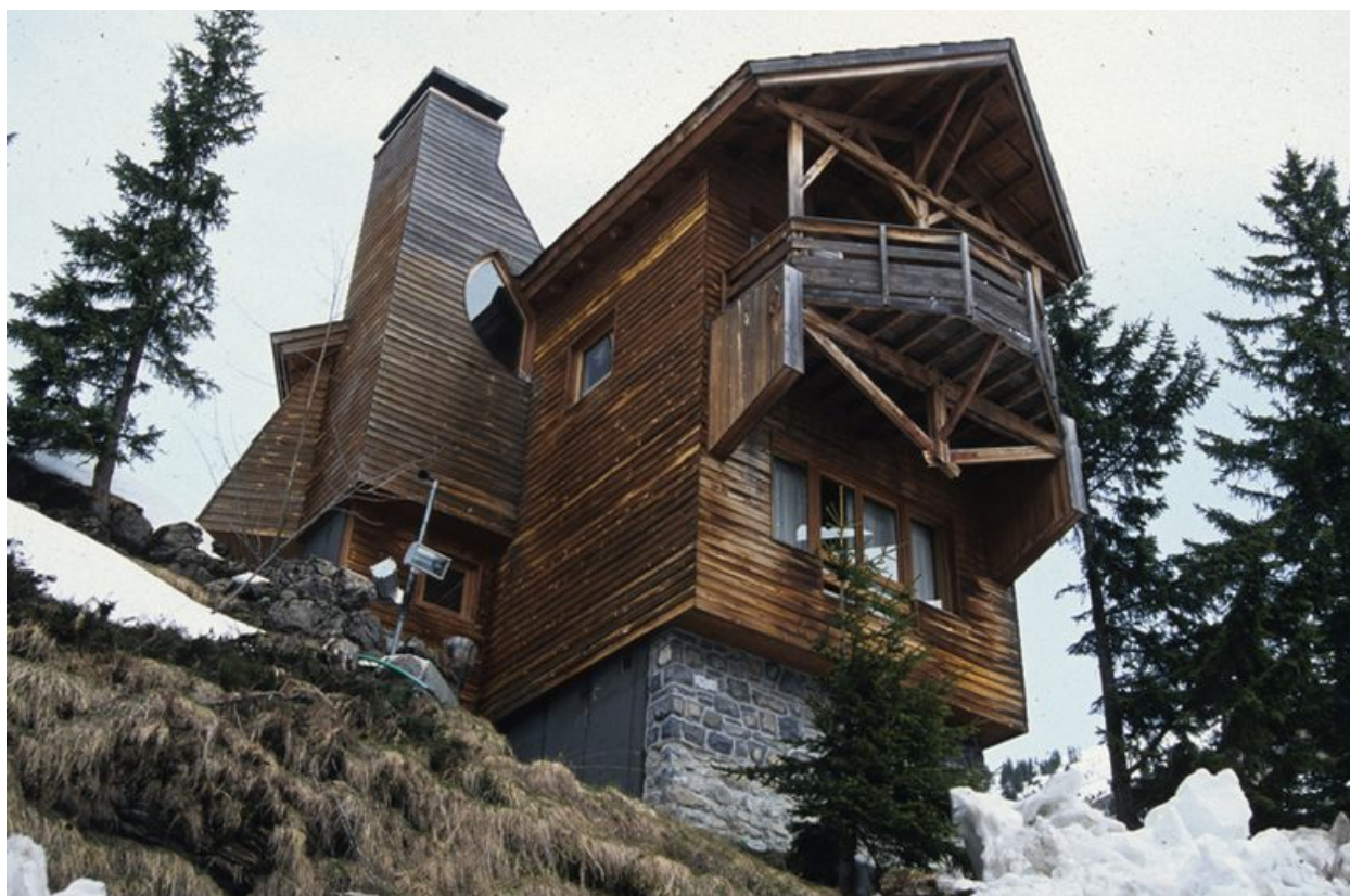
Elévation postérieure, vue de 3/4 gauche
