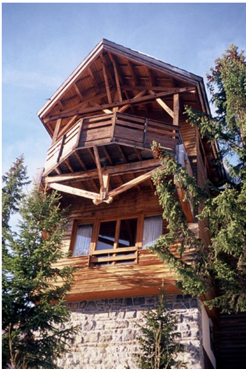
Elévation postérieure. Le balcon
