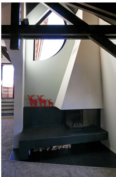
La cheminée après restauration Phot. F. Burger IVR82_20087400043NUCA
