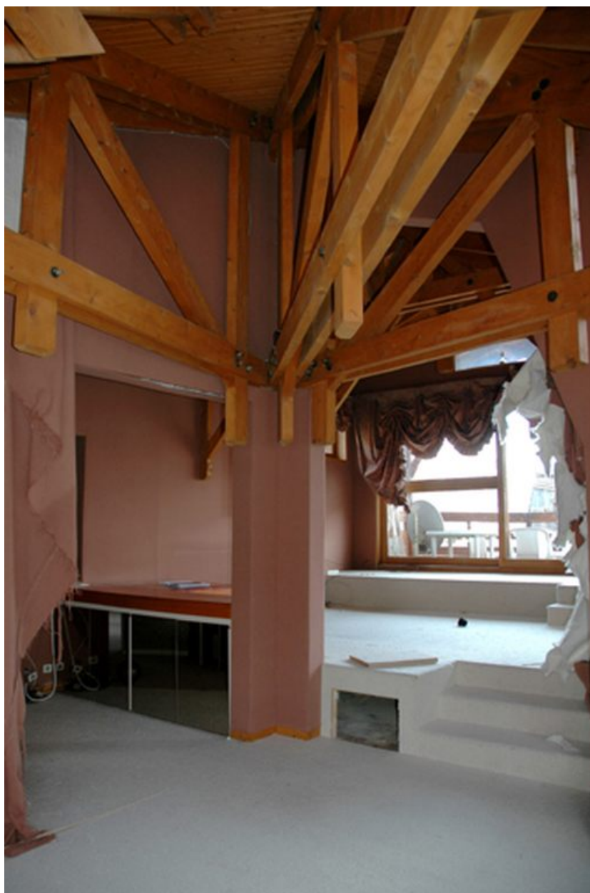
La partie séjour surélevée à l'amont, avant restauration
