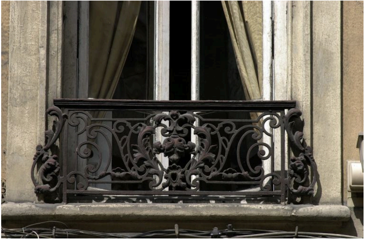
Façade principale rue du Président-Edouard-Herriot, 2e niveau, détail du garde-corps de la 4e fenêtre
