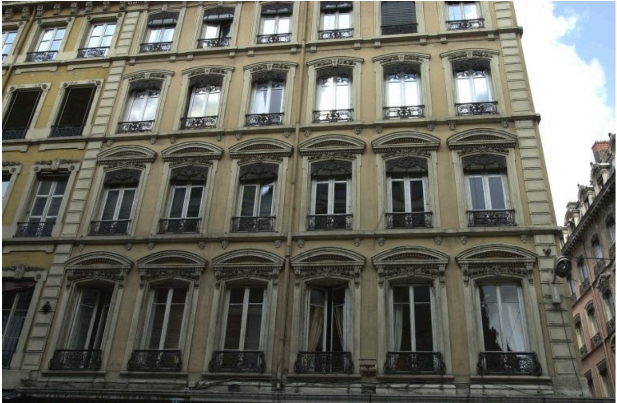
Façade principale rue du Président-Edouard-Herriot, niveaux 2 à 5
