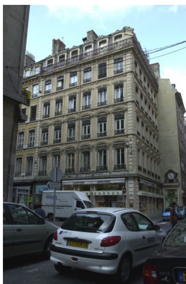
Vue générale des façades Phot. Bernard Ducouret IVR82_20046900847NUCA
