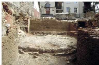
Vue sud des murs Repro. Nadine Halitim-Dubois IVR82_20046906277NUCA
