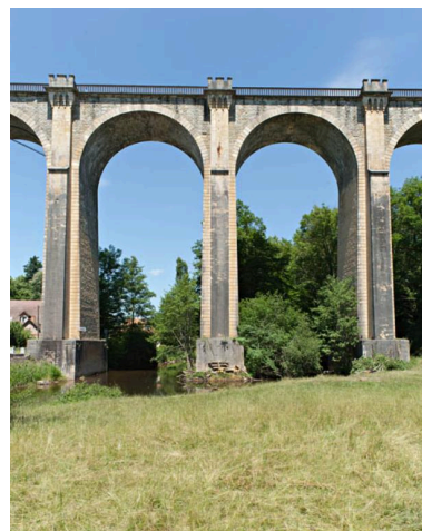
Détail de l'élévation sud du viaduc. Phot. Jean-Michel Périn IVR83_20150300012NUC4A
