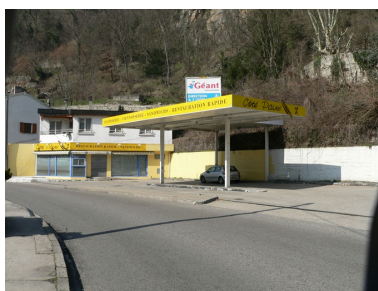
Vue générale Phot. Isabelle Dupuis IVR82_20093800360NUCA
