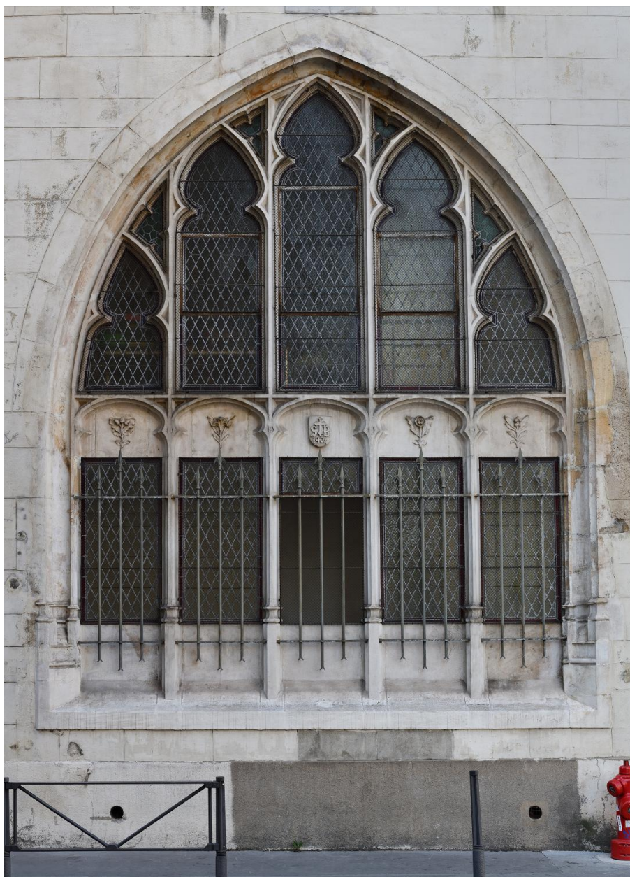
Elévation est : baie portant la date de 1904
