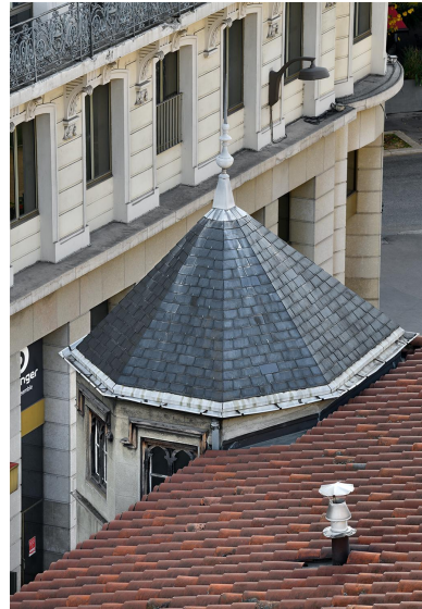
Elévation est : tourelle et sa toiture Phot. Thierry Leroy IVR84_20226901548NUCAQ
