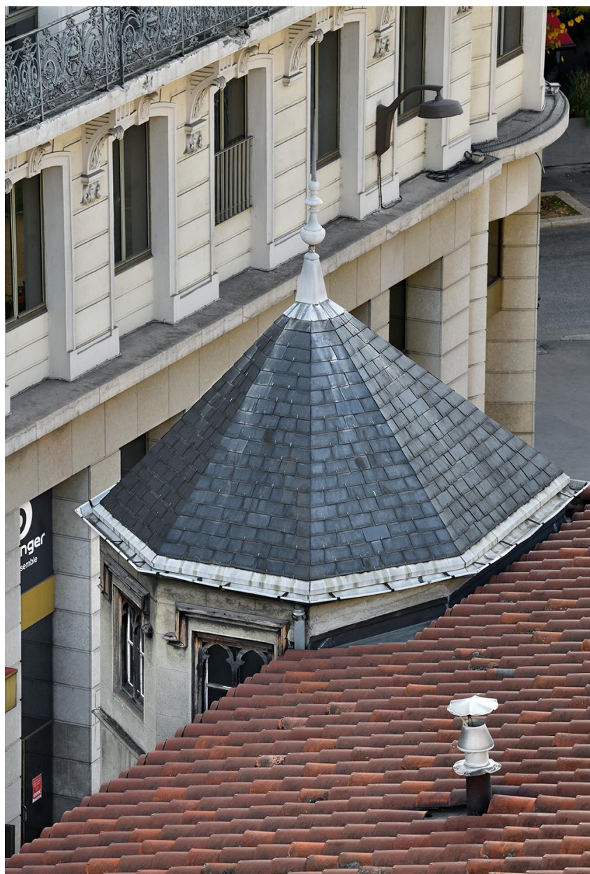
Elévation est : tourelle et sa toiture
