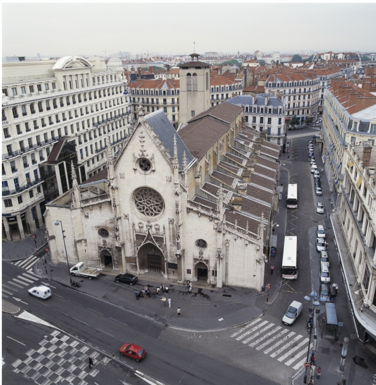
Vue depuis le Palais de la Bourse au nord
