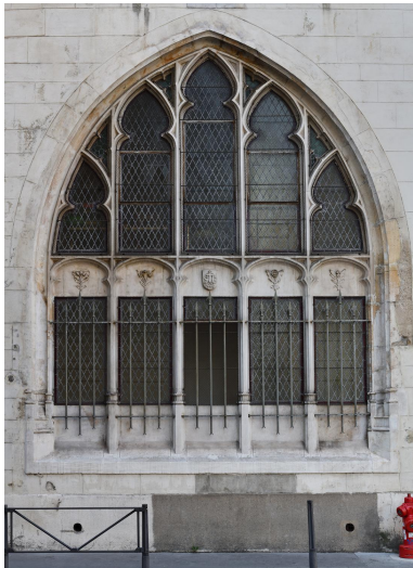
Elévation est : baie portant la date de 1904 Phot. Thierry Leroy IVR84_20226901408NUCA
