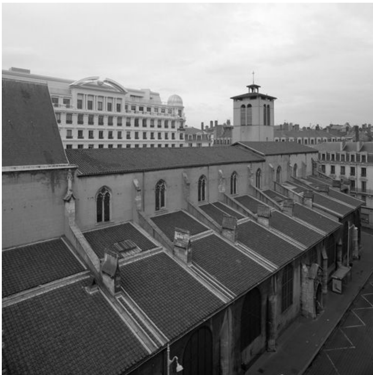
Vue des toits depuis le toit du Grand Bazar, au nord-ouest
