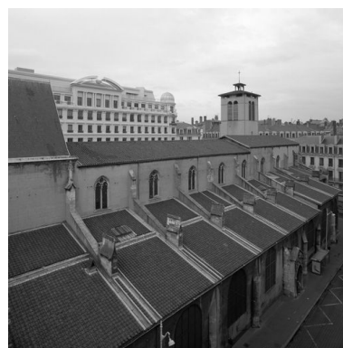
Vue des toits depuis le toit du Grand Bazar, au nord-ouest Phot. Eric Dessert IVR82_20046901126NUC
