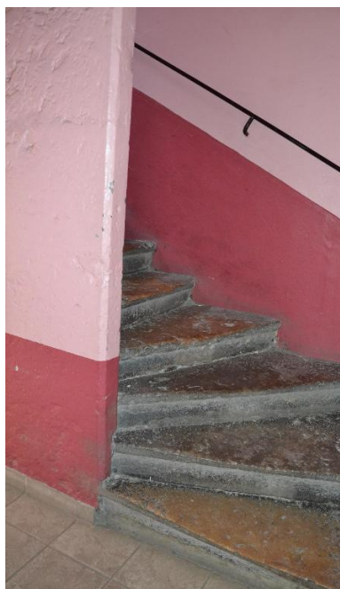
Départ escalier Phot. Noémie Caillat IVR82_20156900135NUCA
