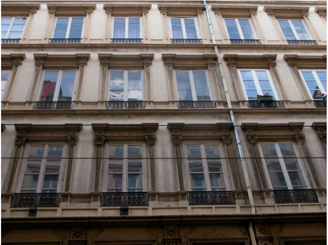
Façade sur rue, détail des niveaux 3 à 5
