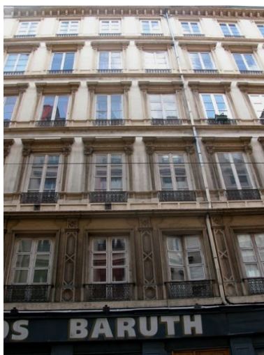
Façade sur rue, vue générale prise par dessous Phot. Phot. Inv. D. Chevallier IVR82_20046900650NUCA
