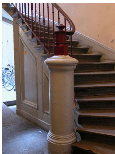
Départ de l'escalier Phot. Phot. Inv. D. Chevallier IVR82_20046900655NUCA
