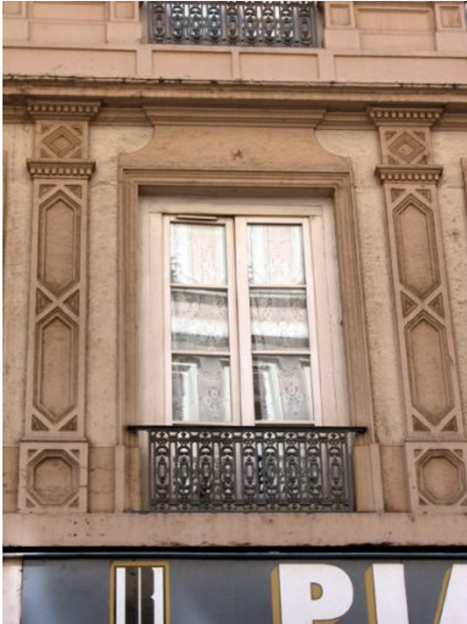
Façade sur rue, détail d'une fenêtre du 2e niveau
