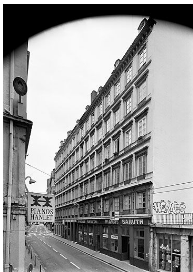
Vue générale Phot. Didier Gourbin IVR82_20046900828P
