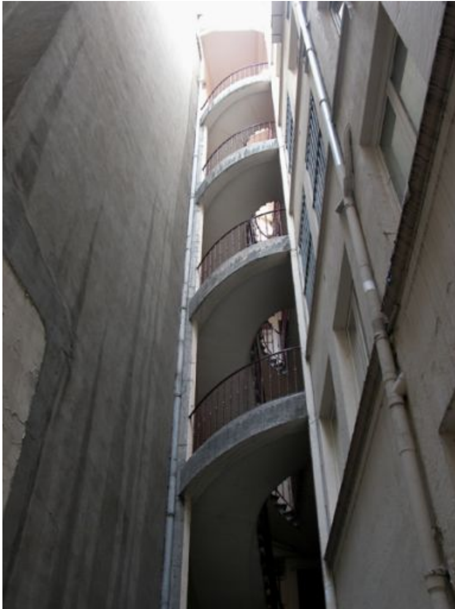
Façade sur cour de l'escalier
