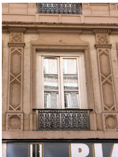
Façade sur rue, détail d'une fenêtre du 2e niveau Phot. Phot. Inv. D. Chevallier IVR82_20046900652NUCA
