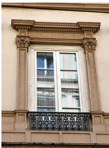
Façade sur rue, détail d'une fenêtre du 3e niveau Phot. Phot. Inv. D. Chevallier IVR82_20046900653NUCA
