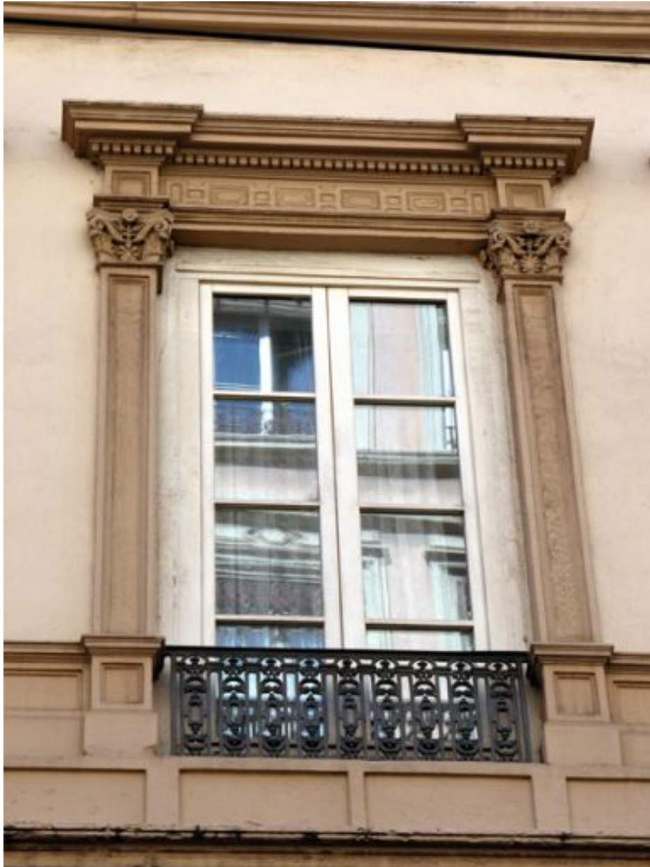
Façade sur rue, détail d'une fenêtre du 3e niveau
