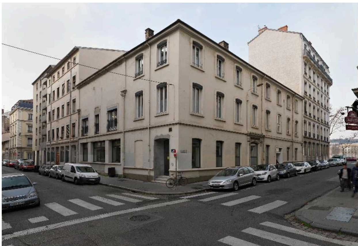
Vue d'ensemble, depuis la rue Cavenne
