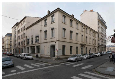
Vue d'ensemble, depuis la rue Cavenne Phot. Eric Dessert IVR84_20166901361NUCA
