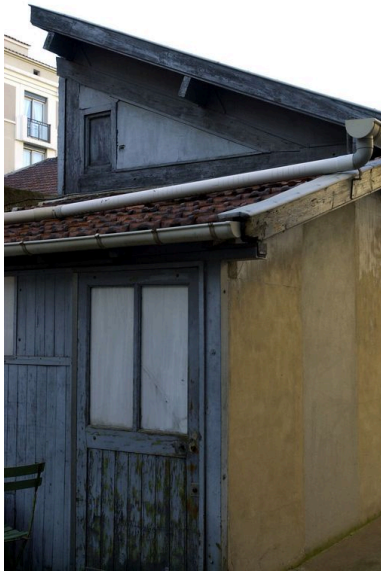
Elévation orientale de l'atelier de tissage Phot. Bernard Ducouret IVR82_20016900107NUCA
