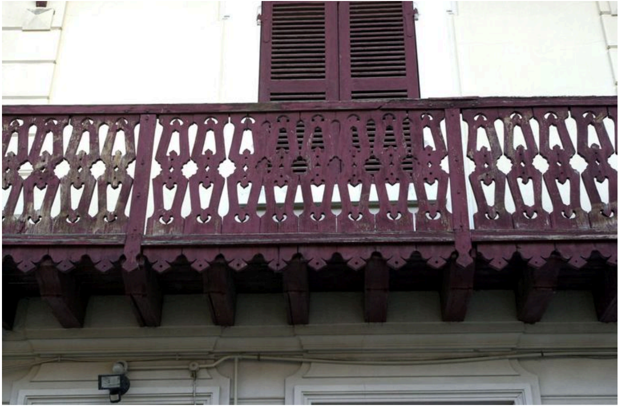
Logis, façade principale sur cour, détail du balcon
