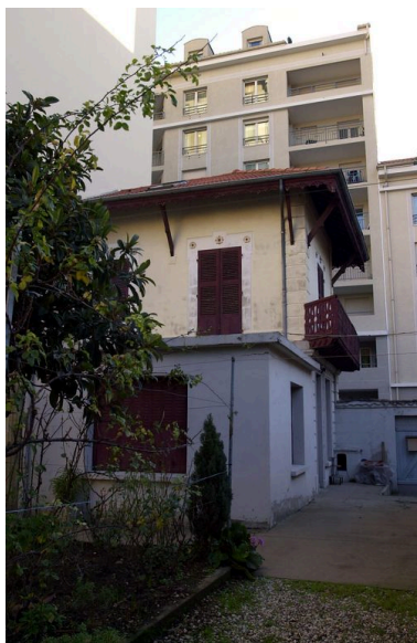
Logis, vue générale depuis le jardin Phot. Bernard Ducouret IVR82_20016900102NUCA
