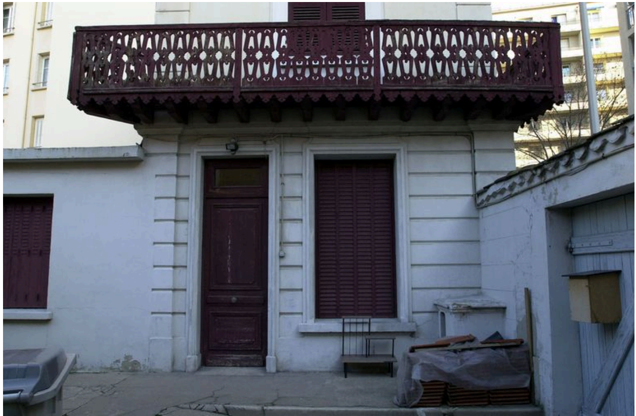
Logis, façade principale sur cour, détail du rez-de-chaussée
