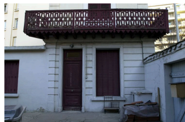
Logis, façade principale sur cour, détail du rez-de-chaussée Phot. Bernard Ducouret IVR82_20016900103NUCA
