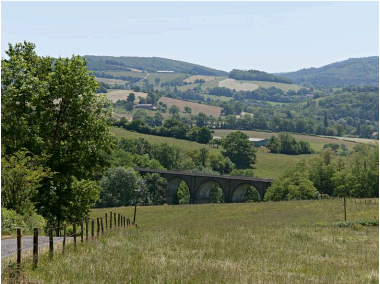
Vue partielle du viaduc de Nérard dans le site.
