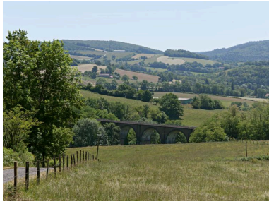
Vue partielle du viaduc de Nérard dans le site. Phot. Jean-Michel Périn IVR83_20150300006NUC4A
