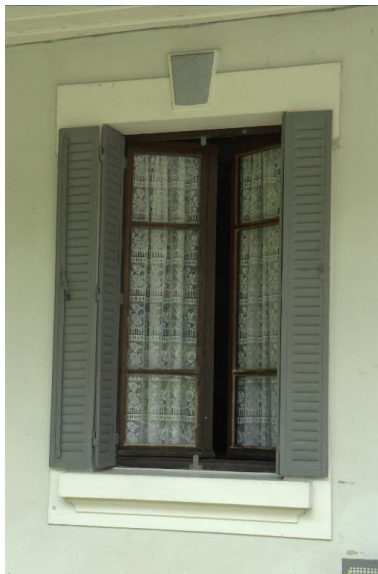
Détail d'une baie à encadrement en béton moulé. Phot. Thierry Monnet IVR82_20157302674NUCA
