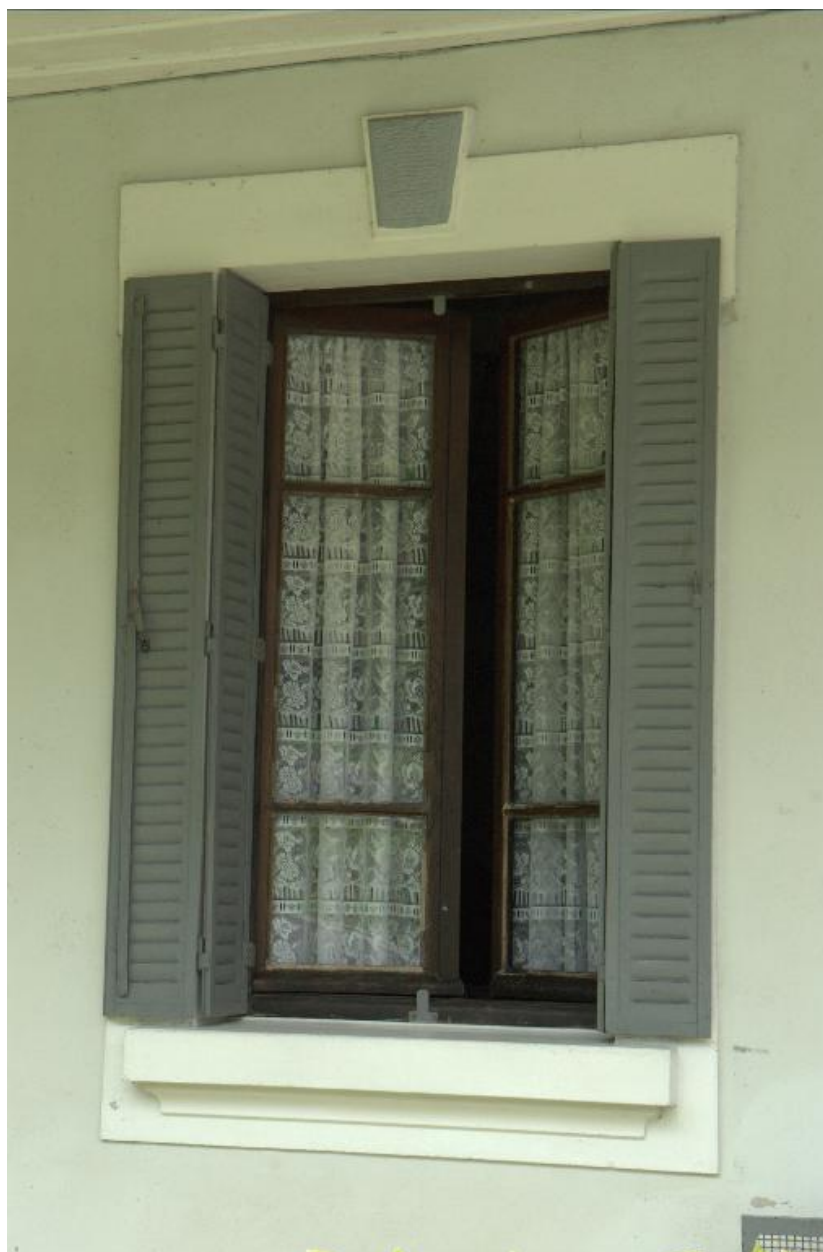
Détail d'une baie à encadrement en béton moulé.
