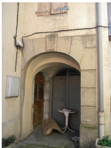
Vue d'un porche vouté d'arêtes sur l'arrière-cour. Phot. Jérôme Daviet IVR82_20147400547NUCA
