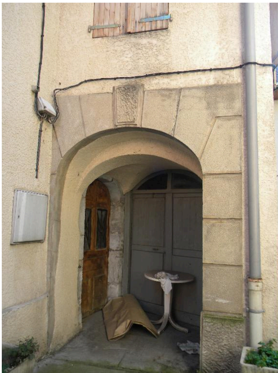
Vue d'un porche vouté d'arêtes sur l'arrière-cour.
