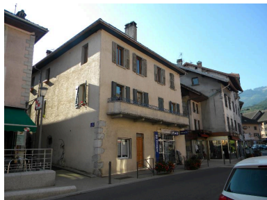
Vue d'ensemble. Phot. Jérôme Daviet IVR82_20147400546NUCA
