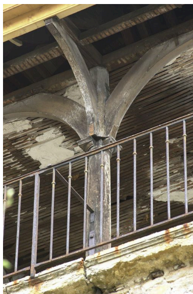
Détail d'une colonne en bois supportant la toiture Phot. Bernard Ducouret IVR82_20026901535NUCA
