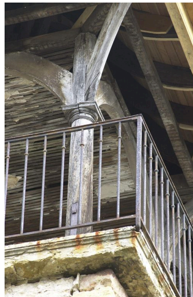
Détail de la colonne d'angle supportant la toiture Phot. Bernard Ducouret IVR82_20026901534NUCA
