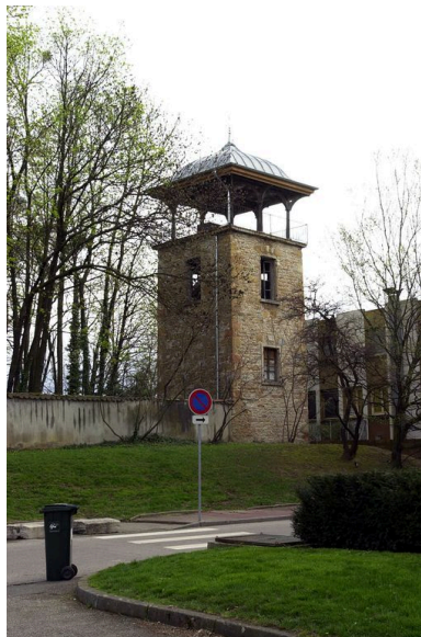
Vue générale de la tour-belvédère Phot. Bernard Ducouret IVR82_20026901532NUCA
