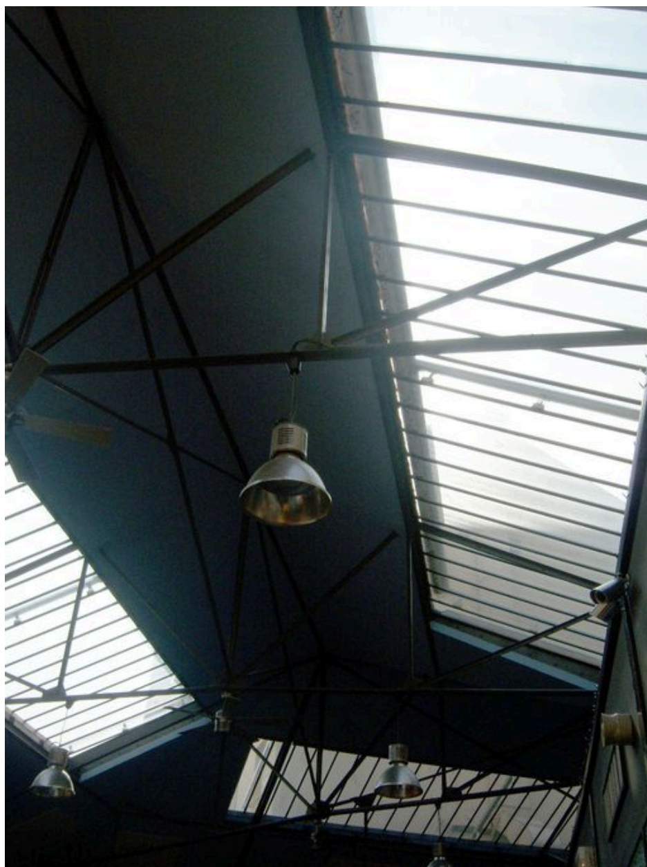
Vue sur la verrière en toiture
