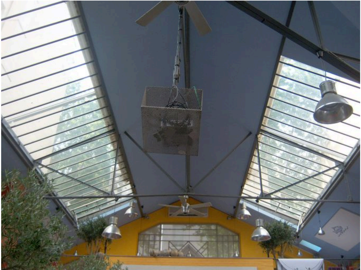
Vue de l'intérieur , verrière en toiture
