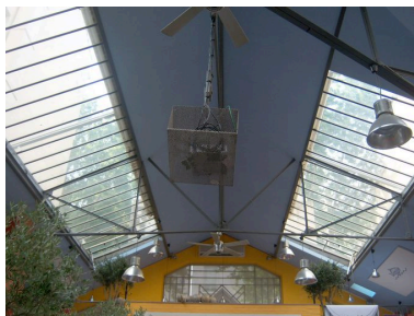
Vue de l'intérieur , verrière en toiture Phot. Salohy Rakotomalala IVR82_20106901332NUCA
