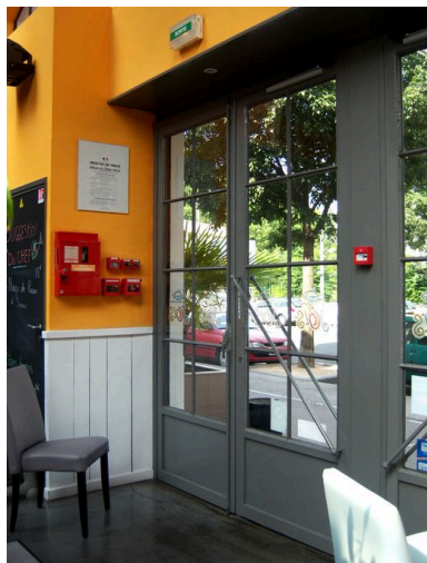
Vue sur la porte d'entrée Ouest Phot. Salohy Rakotomalala IVR82_20106901331NUCA
