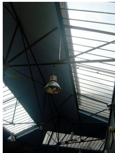
Vue sur la verrière en toiture Phot. Salohy Rakotomalala IVR82_20106901333NUCA
