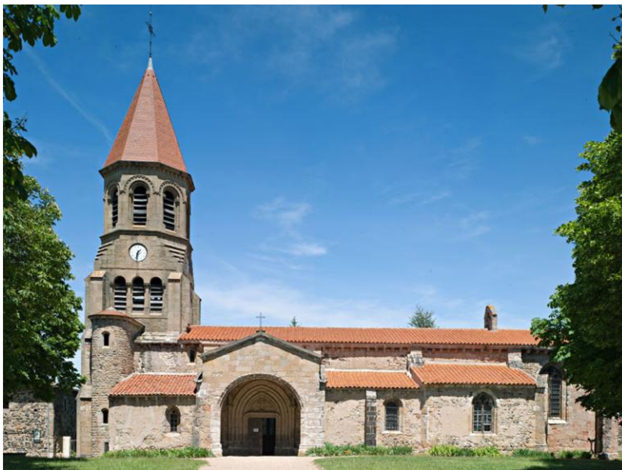
Vue générale de la façade méridionale.
