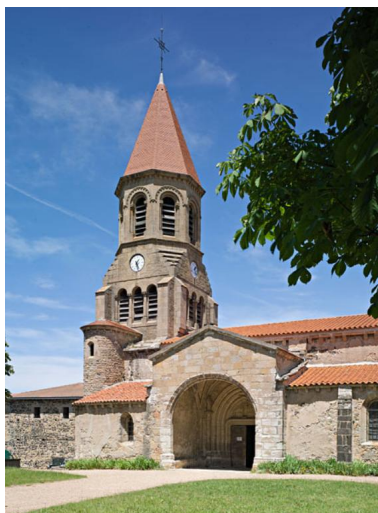
Portail méridional et clocher. Phot. Jean-Michel Périn IVR83_20146300375NUC4A
