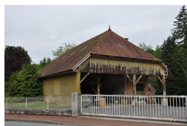
Vue générale du bâtiment de la scierie, vue sud Phot. Yannick Milleret IVR82_20127301641NUCA
