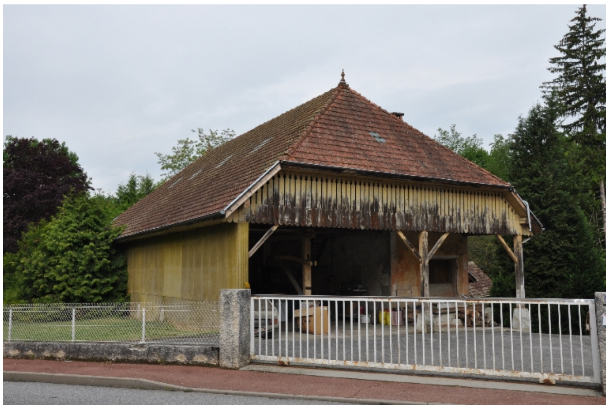
Vue générale du bâtiment de la scierie, vue sud
