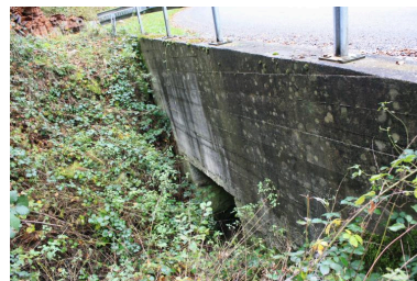
Ponceau des Mouilles, face amont Phot. Benoît Huraut IVR84_20207401497NUCA
