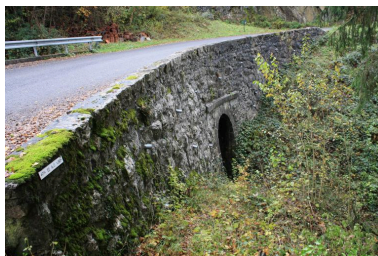
Ponceau des Mouilles, face en aval Phot. Benoît Huraut IVR84_20207401496NUCA
