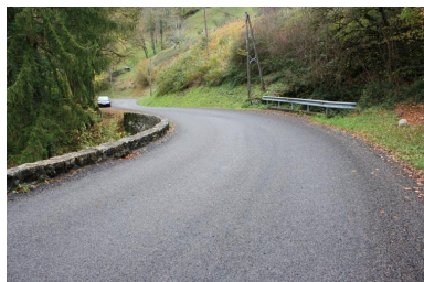
Ponceau des Mouilles, contexte chaussée et garde corps Phot. Benoît Huraut IVR84_20207401495NUCA
