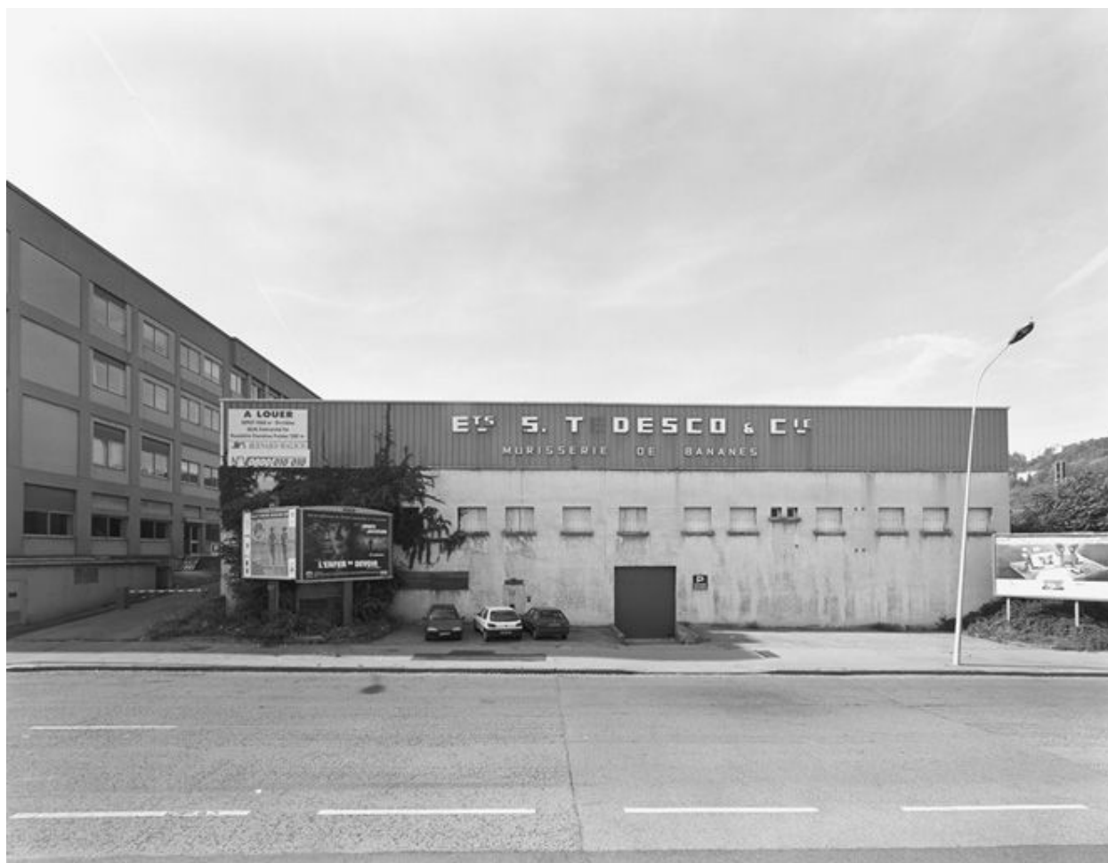
Vue générale de la façade nord
