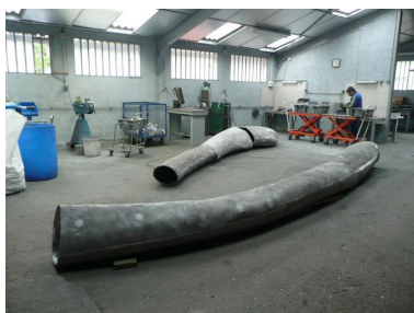
Préparation en atelier. Autr. auteur inconnu IVR84_20203800142NUCAB
