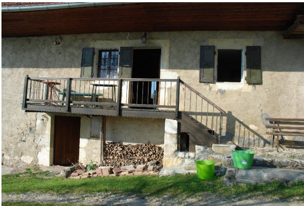
Vue de l'habitation, façade sud.
