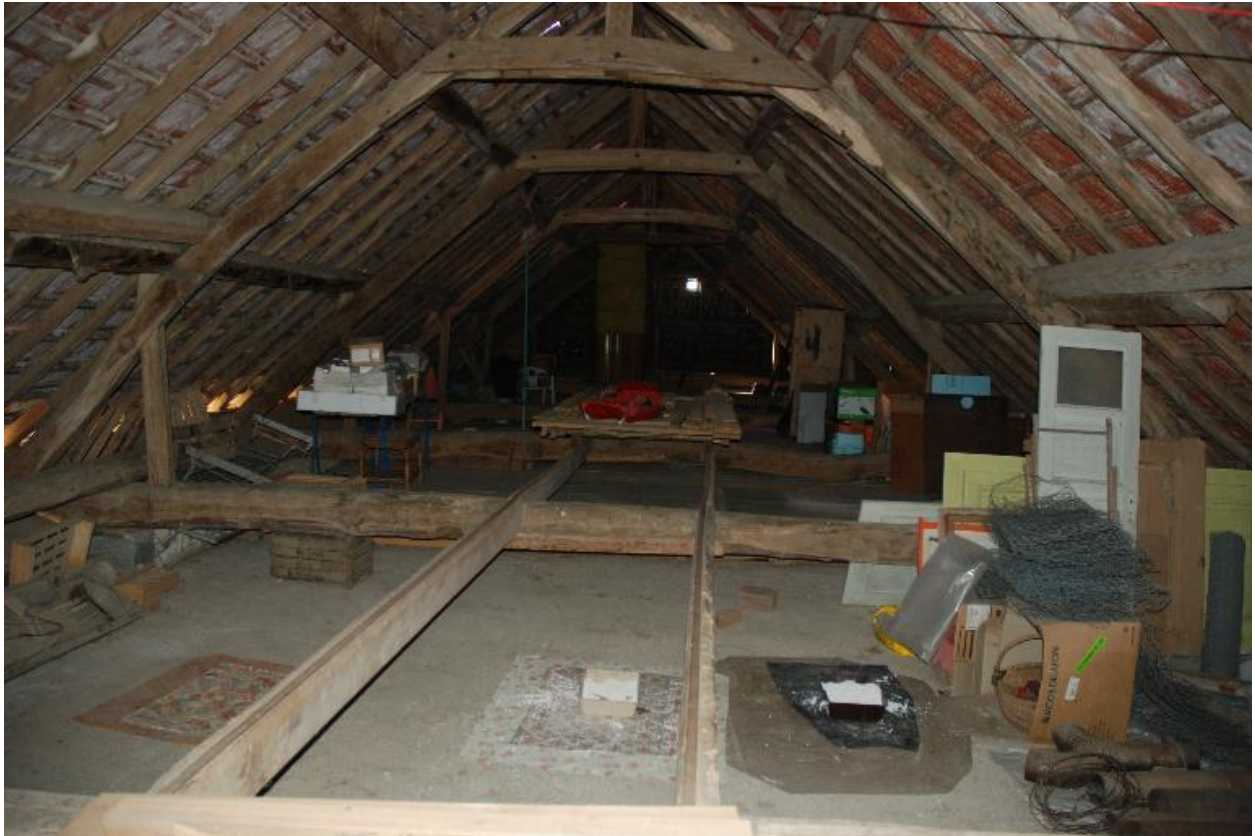
Vue intérieure du comble.
