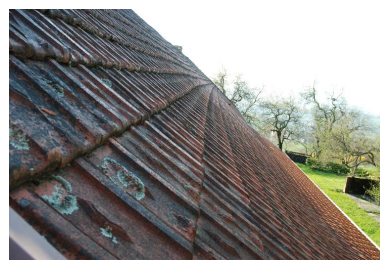
Détail du toit. Phot. Thierry Monnet IVR82_20147302250NUCA
