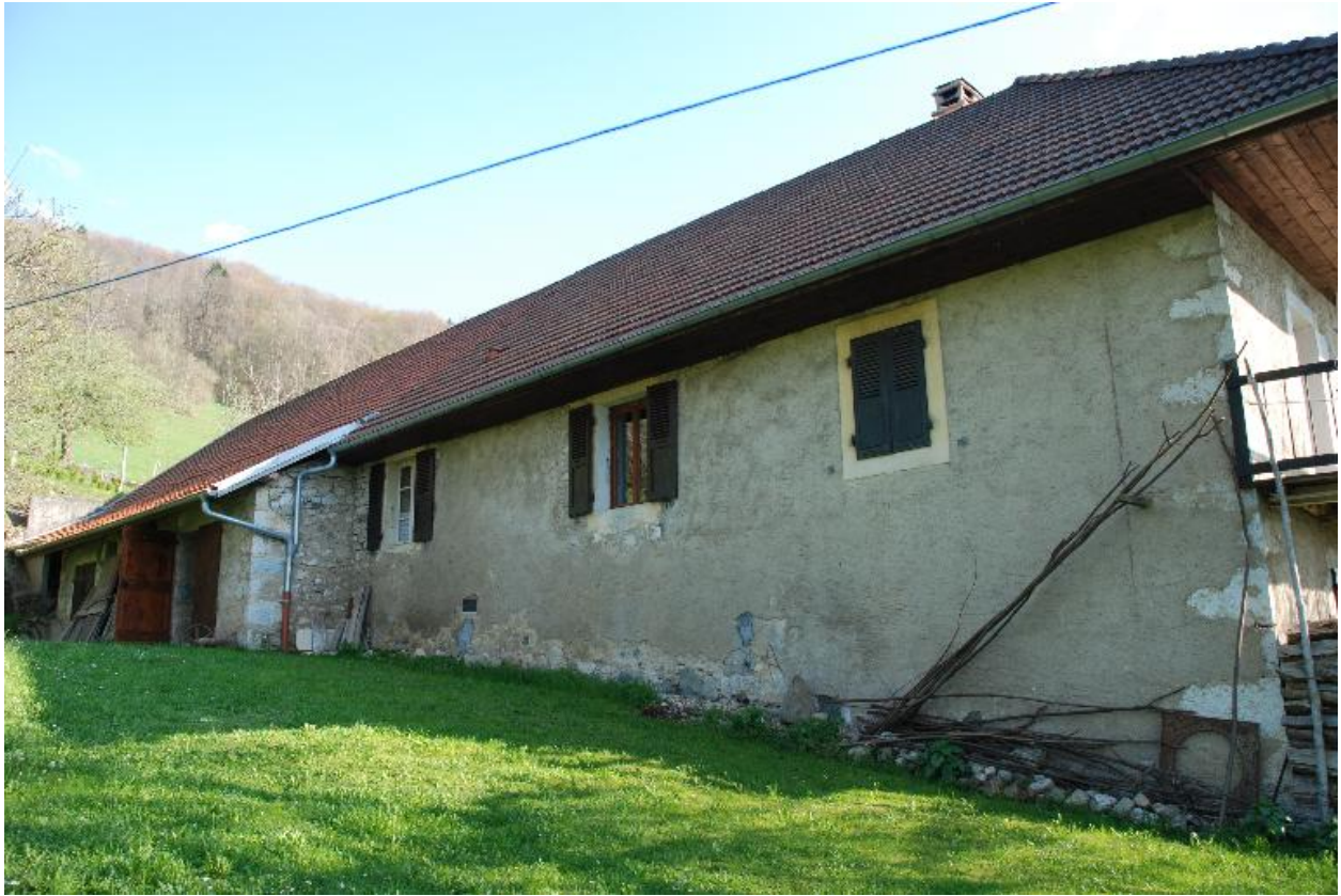
Vue d'ensemble depuis le nord-ouest (façade arrière).
