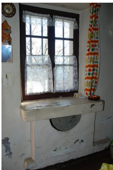
Vue intérieure du premier logement : potager. Phot. Thierry Monnet IVR82_20147302259NUCA
