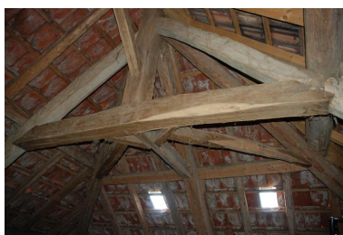
Vue intérieure du comble, charpente de la croupe. Phot. Thierry Monnet IVR82_20147302249NUCA
