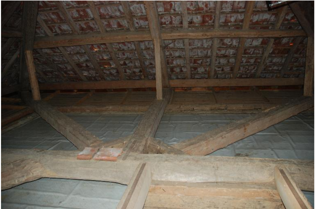
Vue intérieure du comble, charpente de la croupe (sol).
