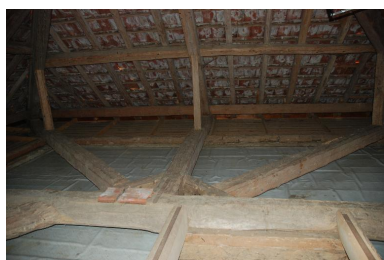
Vue intérieure du comble, charpente de la croupe (sol). Phot. Thierry Monnet IVR82_20147302248NUCA
