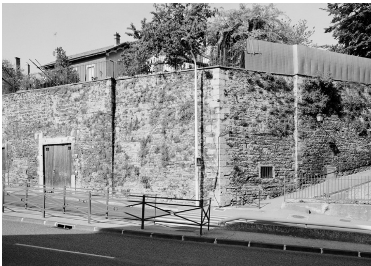
Vue d'angle avec la montée des Génovéfains
