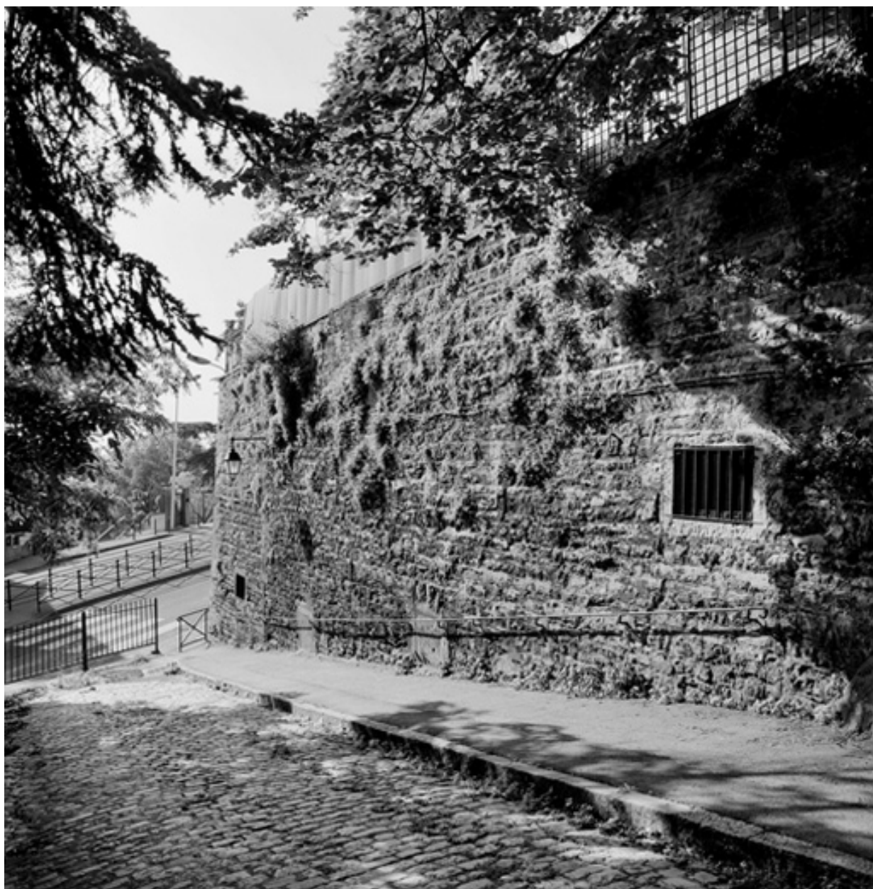
Détail soupirail montée des Génovéfains
