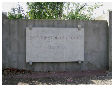
Parapet, vue de détail : inscription Phot. I. Havard IVR82_20106907402NUCA
