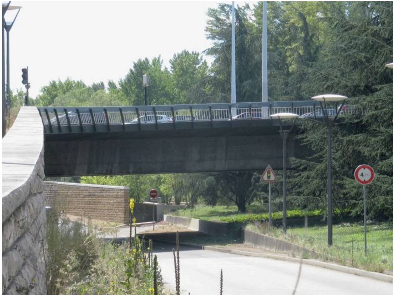
Travée de rive et culée gauche, face amont, vue partielle (depuis la rive gauche)
