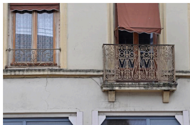
Détail du balcon du premier étage Phot. Magali Delavenne IVR84_20166902069NUCA
