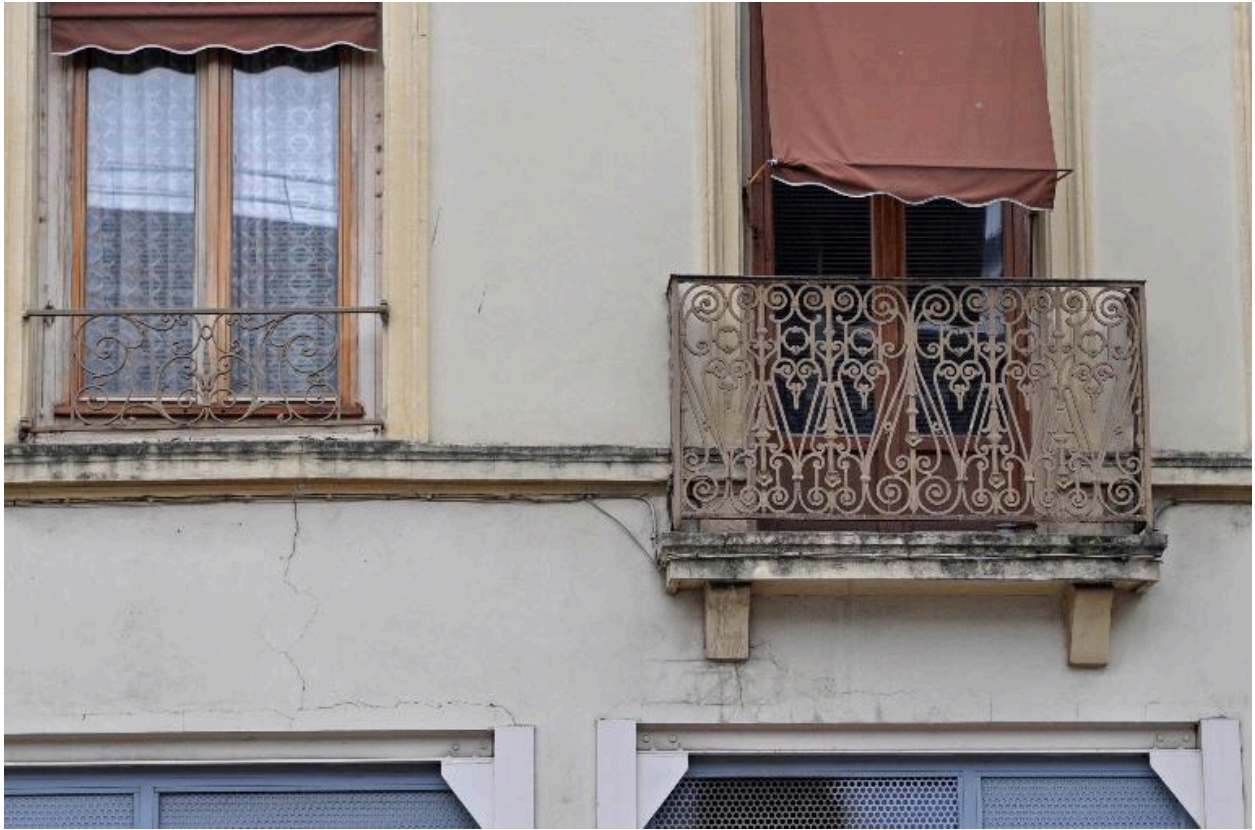
Détail du balcon du premier étage
