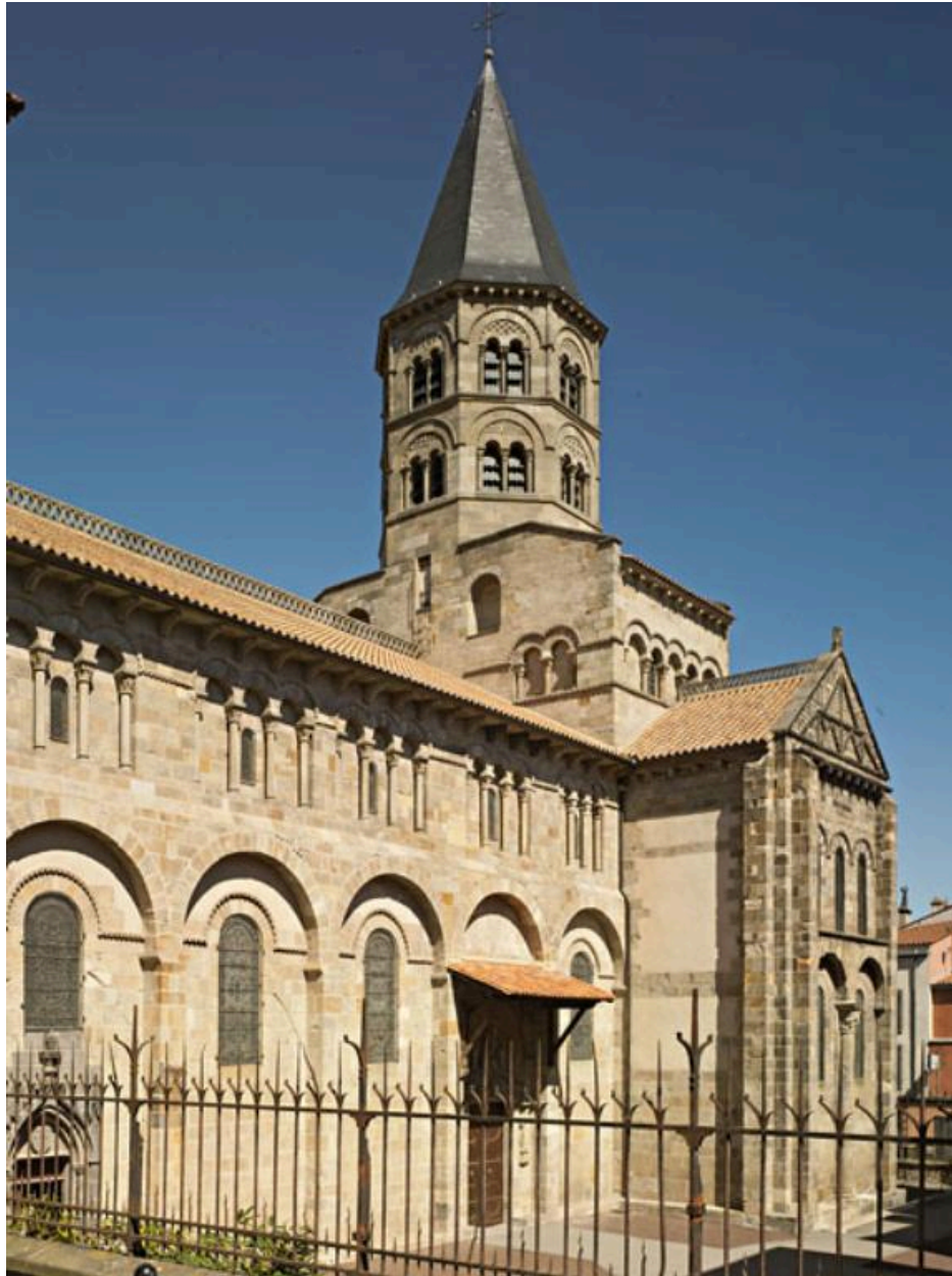
Vue générale de la façade méridionale.
