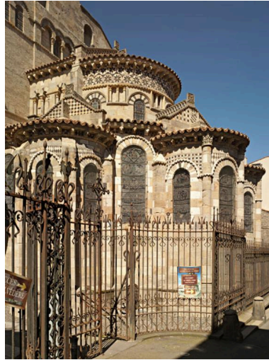
Vue générale du chevet. Phot. Jean-Michel Périn IVR83_20146300258NUC4A
