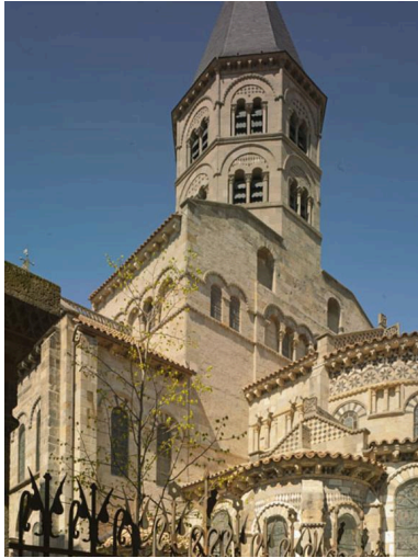
Vue générale du clocher. Phot. Jean-Michel Périn IVR83_20146300259NUC4A
