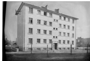
Élévation ouest de l'un des immeubles collectifs Michelin, rue de Blanzat. Vue prise vraisemblablement au début des années 1960. IVR84_20236300192NUC
