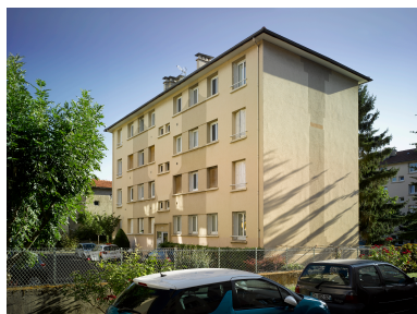
Un des quatre immeubles collectifs de la rue de Blanzat, depuis l'ouest (années 1950). Phot. Christian Parisey IVR84_20196300251NUC4A
